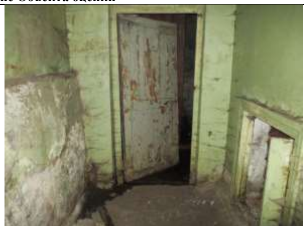
Фото 10. Внутреннее состояние Объекта оценки
