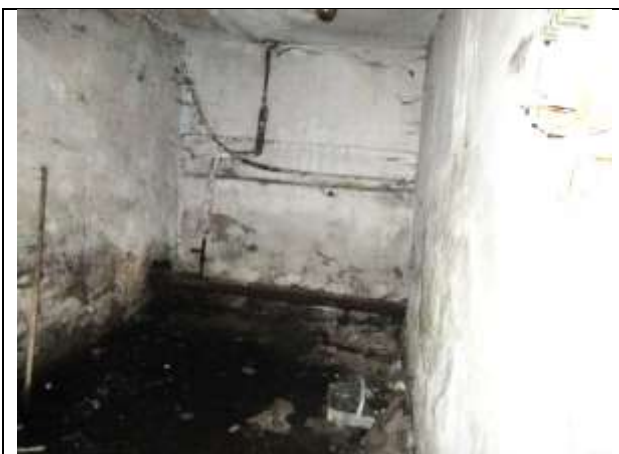
Фото 13. Внутреннее состояние Объекта оценки
