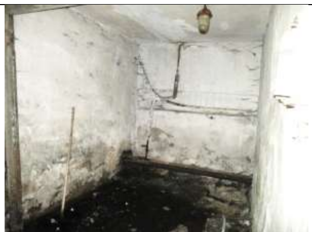
Фото 14. Внутреннее состояние Объекта оценки
