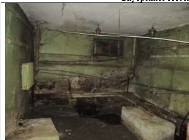
Фото 9. Внутреннее состояние Объекта оценки
