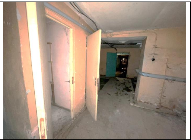
Фото 54. Типичное состояние Объекта оценки
