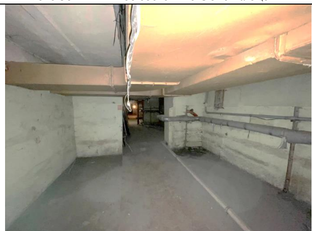
Фото 40. Типичное состояние Объекта оценки
