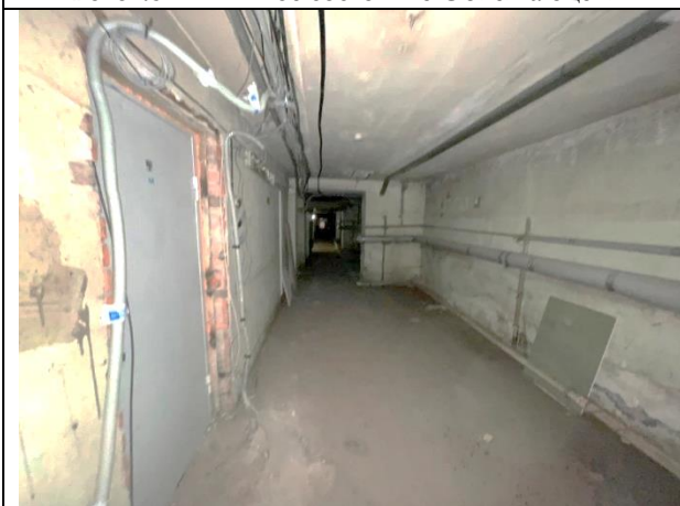
Фото 47. Типичное состояние Объекта оценки
