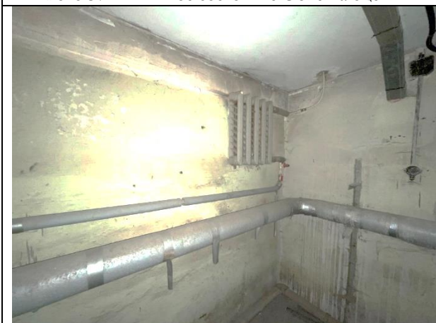
Фото 39. Типичное состояние Объекта оценки
