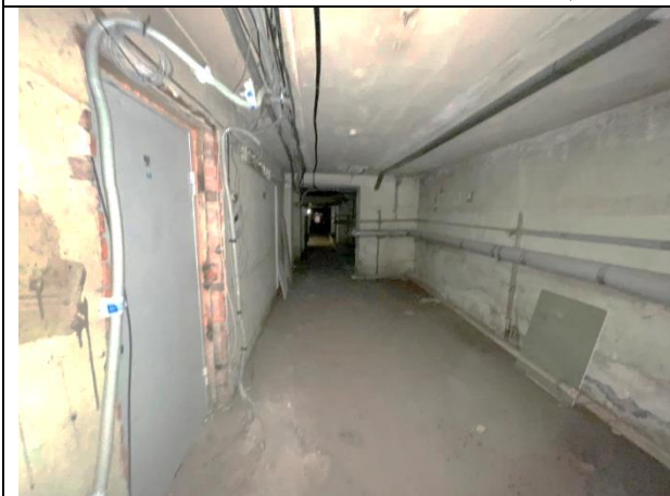
Фото 47. Типичное состояние Объекта оценки
