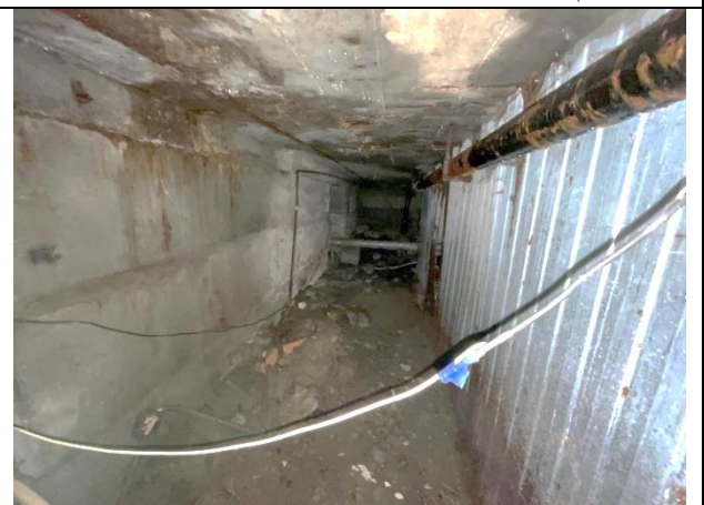
Фото 50. Типичное состояние Объекта оценки
