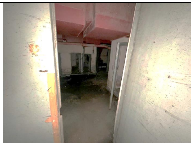
Фото 38. Типичное состояние Объекта оценки
