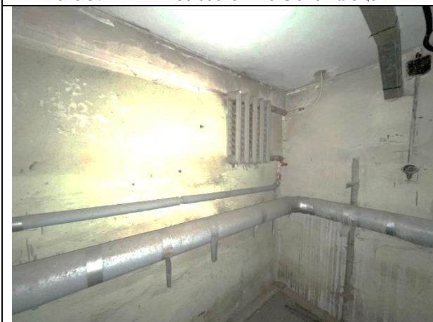
Фото 39. Типичное состояние Объекта оценки
