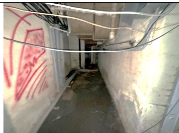
Фото 48. Типичное состояние Объекта оценки
