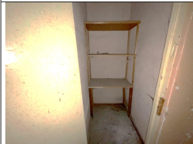
Фото 55. Типичное состояние Объекта оценки
