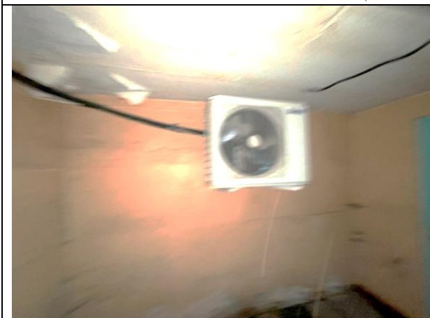
Фото 57. Типичное состояние Объекта оценки
