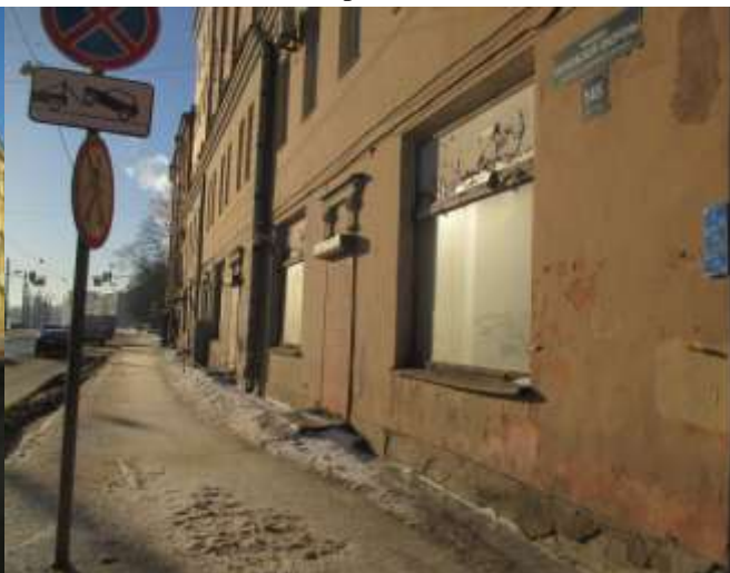
Фото 6. 2 отдельных входа с улицы и окна Объекта оценки
