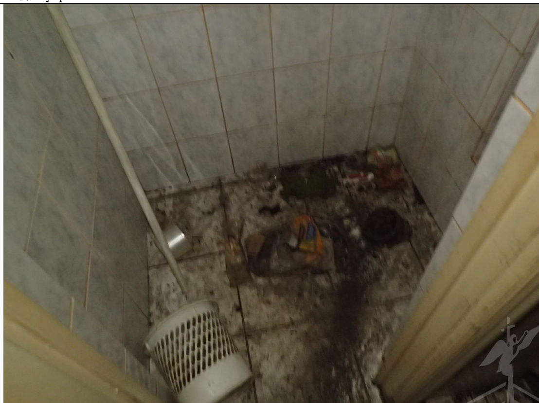
Описание: в ч.п. 12 Объекта демонтировано сантехническое оборудование (унитаз)
