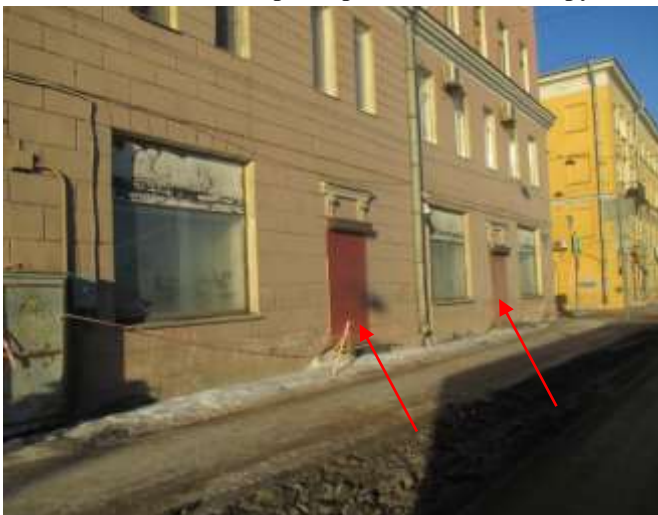
Фото 5. 2 отдельных входа с улицы и окна Объекта оценки
