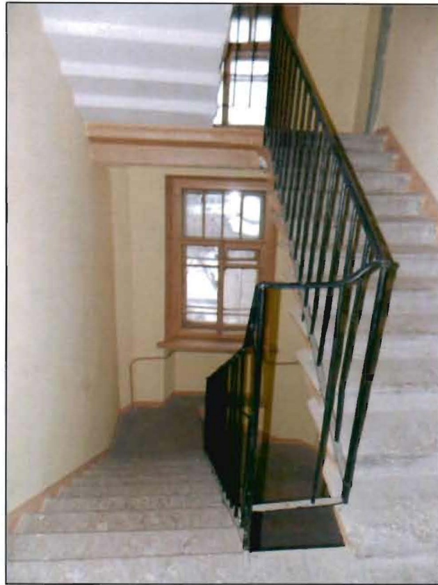
Фото 39. Интерьер. Лестница 3-ЛК.
