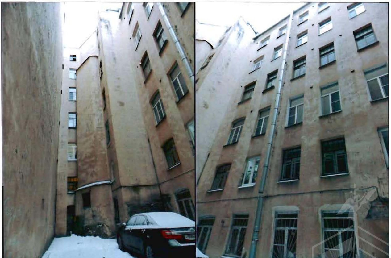
Фото 19-20. Фрагменты дворового фасада. Южный двор. Восточный и южный фасады.
