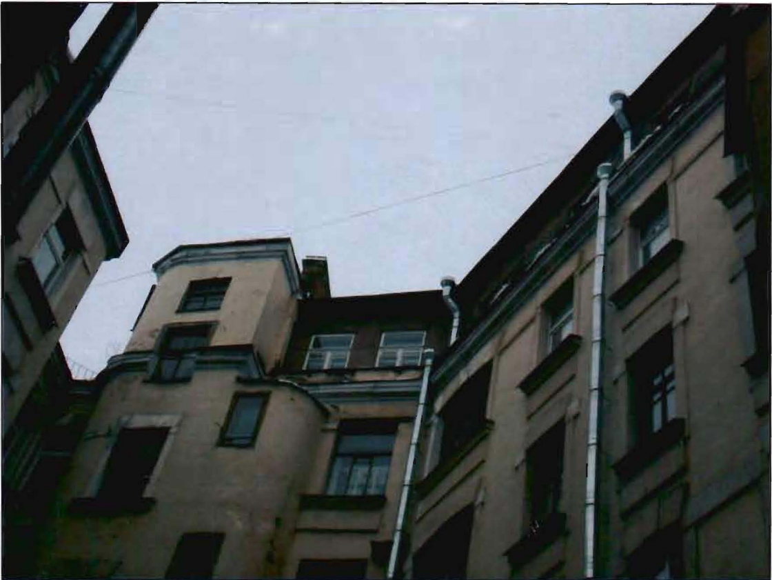
Фото 16. Фрагмент дворового фасада. Северный двор. Восточный фасад. Мансардный этаж.
