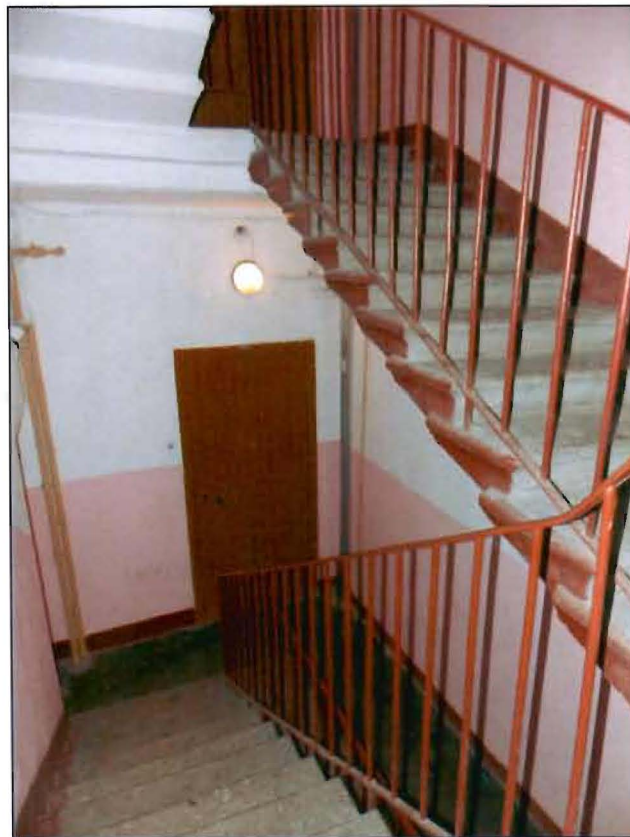
Фото 43. Интерьер. Лестница 6-ЛК.
