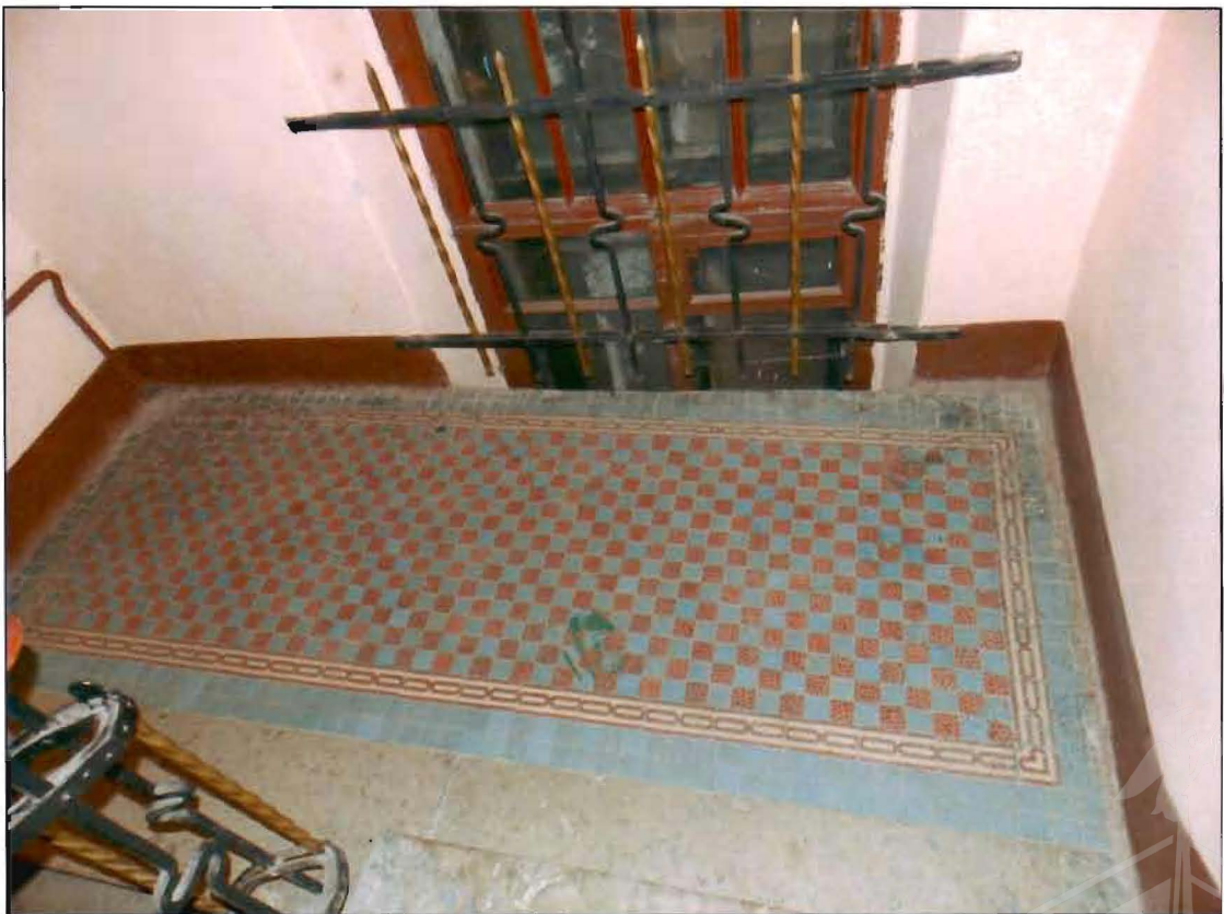
Фото 38. Интерьер. Лестница 2-ЛК.
