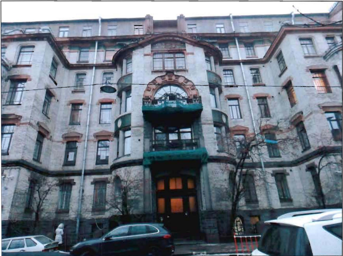
Фото 2. Фрагмент западного фасада.
