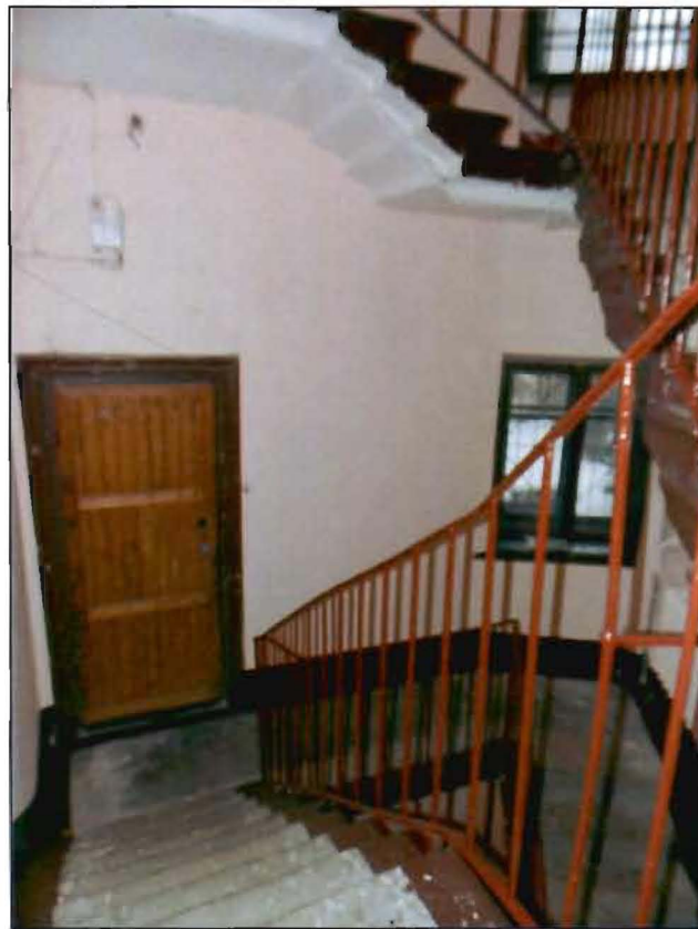
Фото 40. Интерьер. Лестница 4-ЛК.
