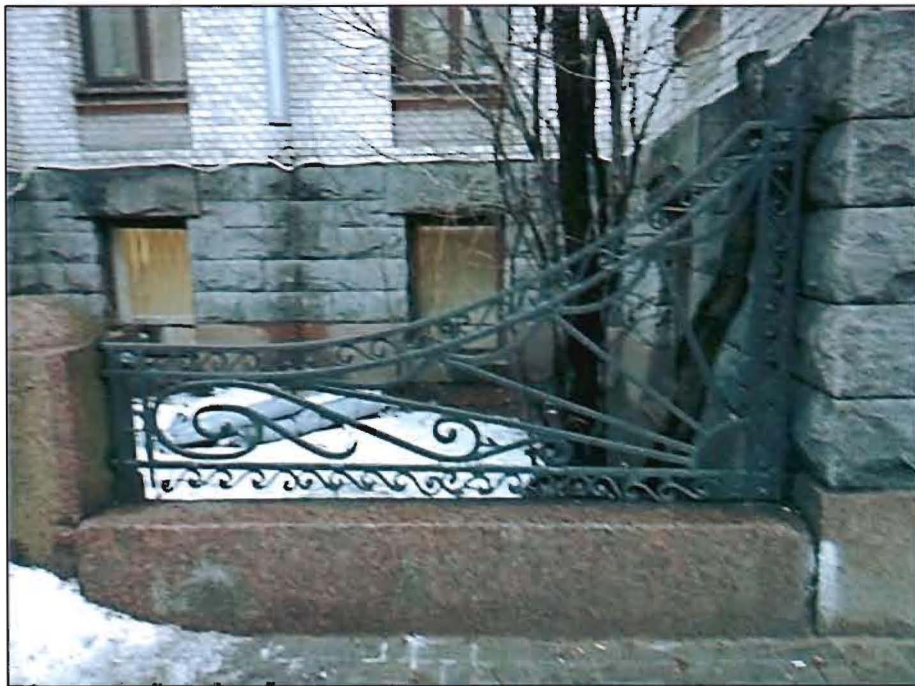
Фото 10. Фрагмент западного фасада. Фрагмент ограды палисадника с северной стороны.
