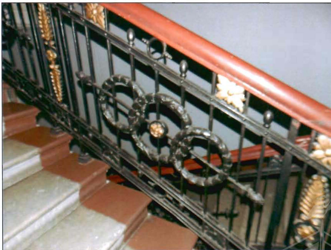
Фото 34. Интерьер. Парадная лестница. Фрагмент ограждения.
