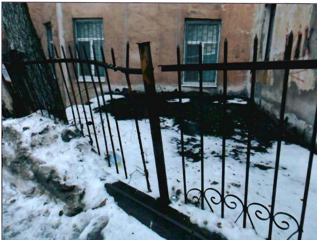
Фото 23. Восточный двор. Ограда.
