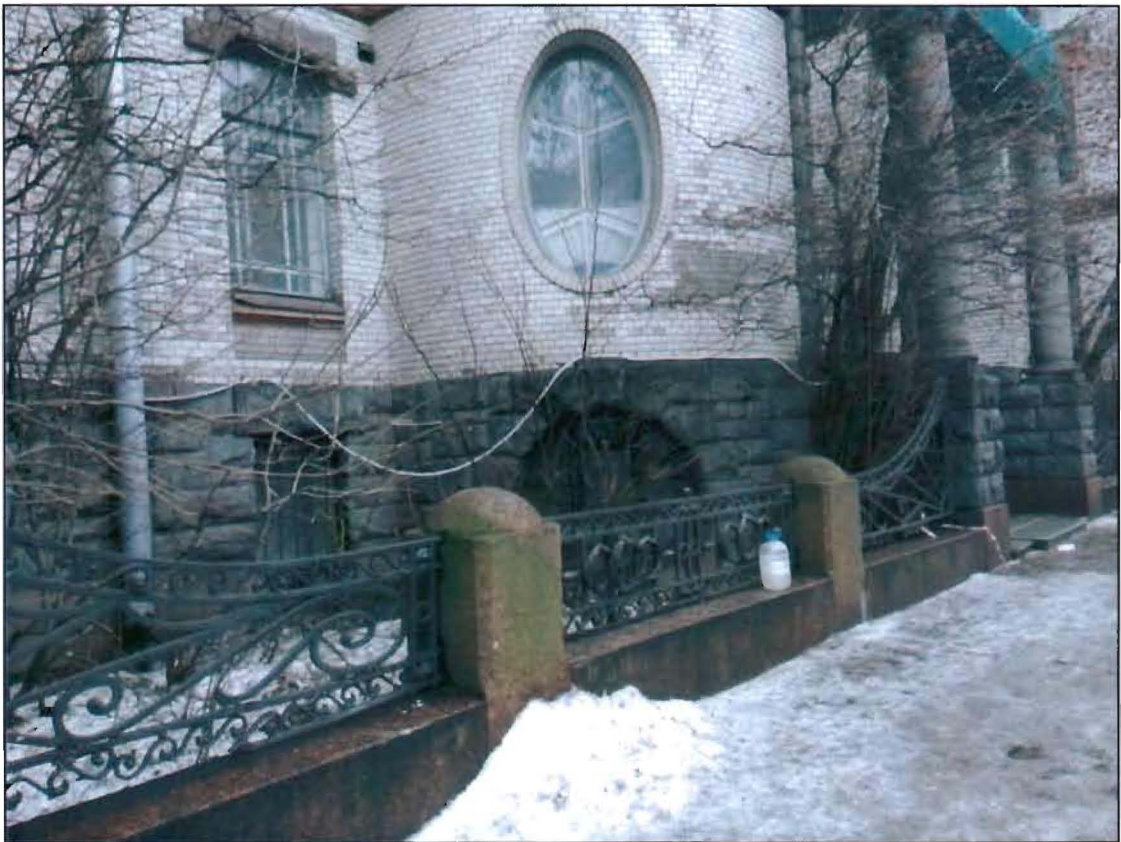
Фото 9. Фрагмент западного фасада. Ограда и палисадник с северной стороны.
