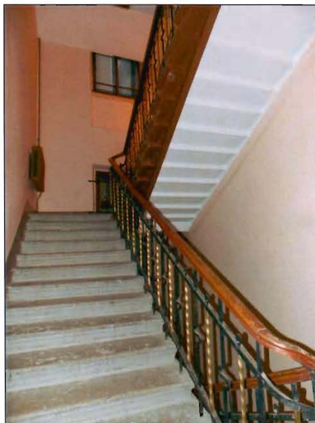
Фото 36. Интерьер. Лестница 2-ЛК.
