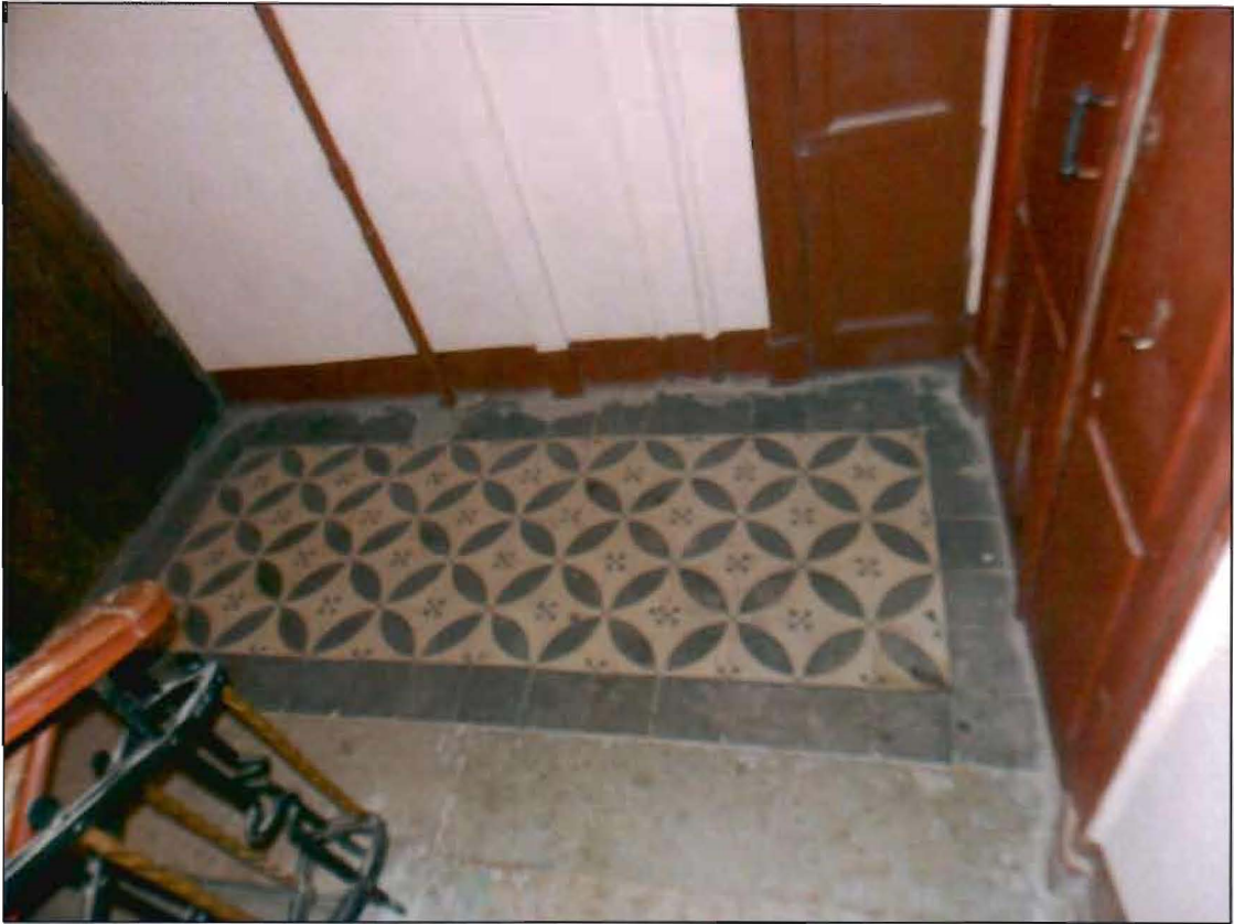
Фото 37. Интерьер. Лестница 2-ЛК.
