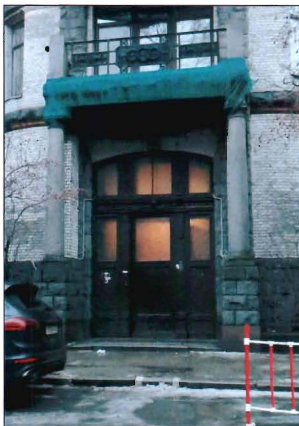
Фото 5. Фрагмент западного фасада. Вход (парадная лестница).
