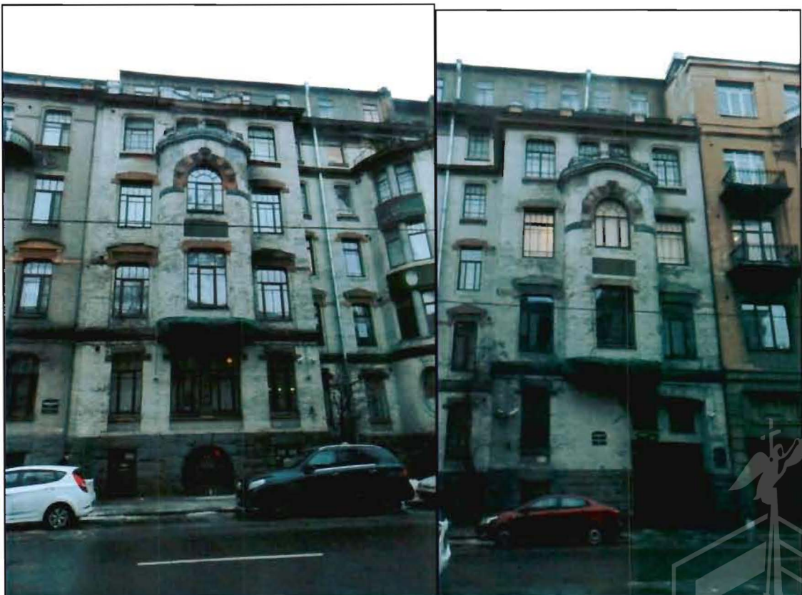
Фото 3-4. Фрагменты западного фасада.
