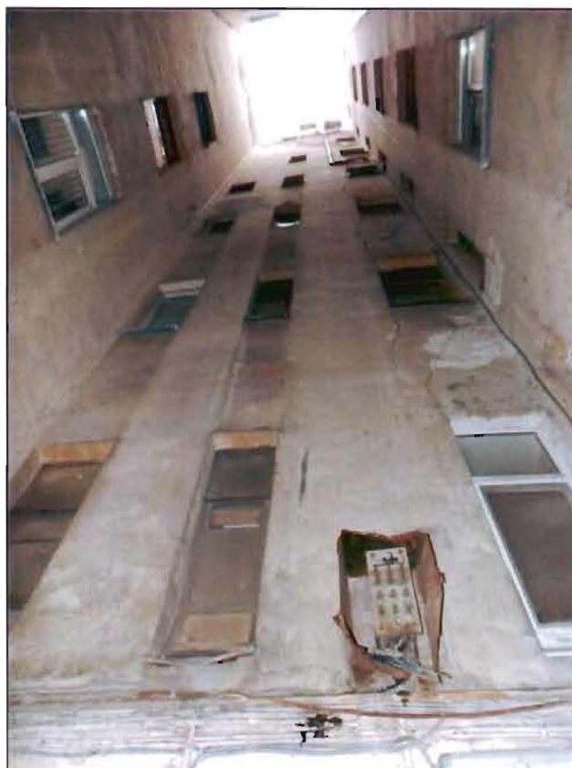
Фото 11. Фрагмент дворового фасада. Середина воротного проезда.
