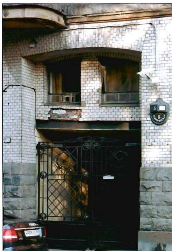
Фото 6. Фрагмент западного фасада. Воротный проезд.
