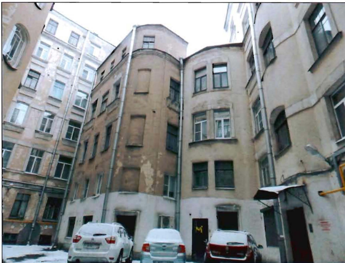
Фото 14. Фрагмент дворового фасада. Северный двор. Западный фасад
