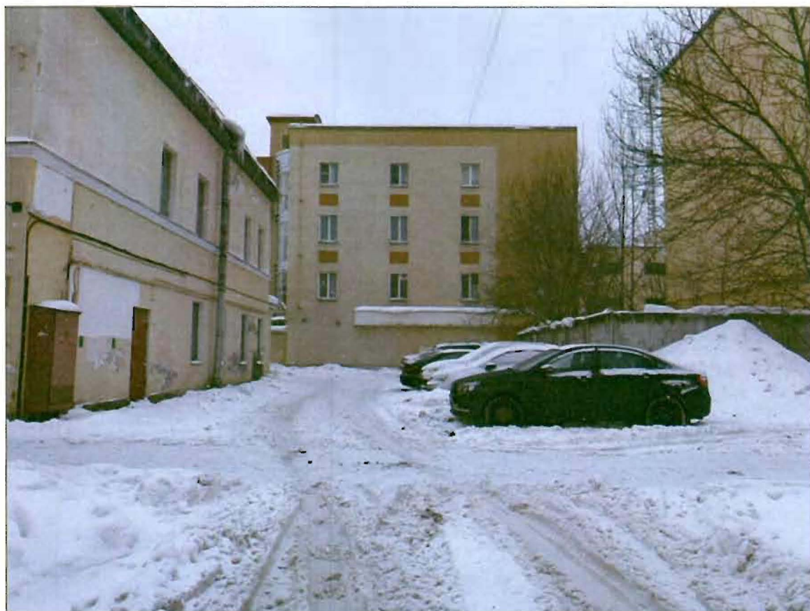
9. Вид на территорию объекта с востока на запад.
