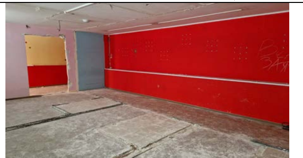
Фото 28. Типичное состояние Объекта оценки
