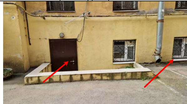
Фото 15. Входная и оконная группа Объекта оценки
