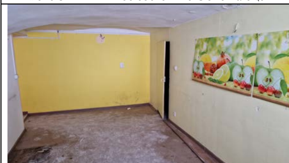
Фото 33. Типичное состояние Объекта оценки
