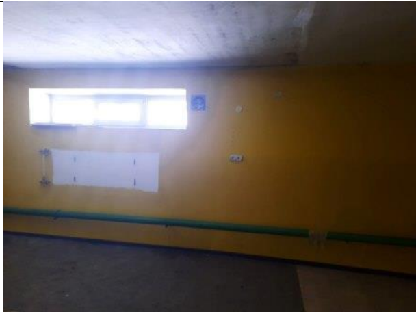
Фото № 21 – Внутреннее состояние помещения
