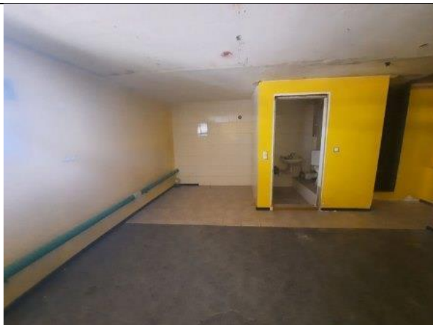
Фото № 19 – Внутреннее состояние помещения
