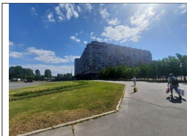
Фото № 1 – Здание, в котором находится Объект оценки
