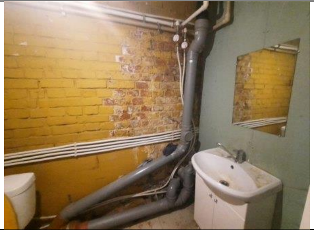
Фото № 14 – Внутреннее состояние помещения
