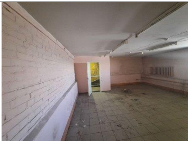
Фото № 7 – Внутреннее состояние помещения
