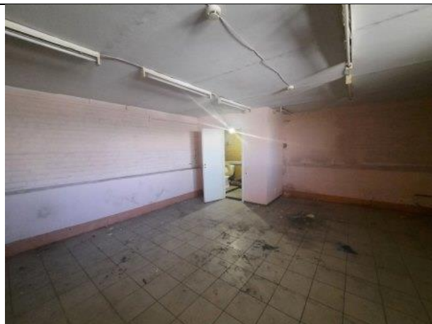
Фото № 8 – Внутреннее состояние помещения
