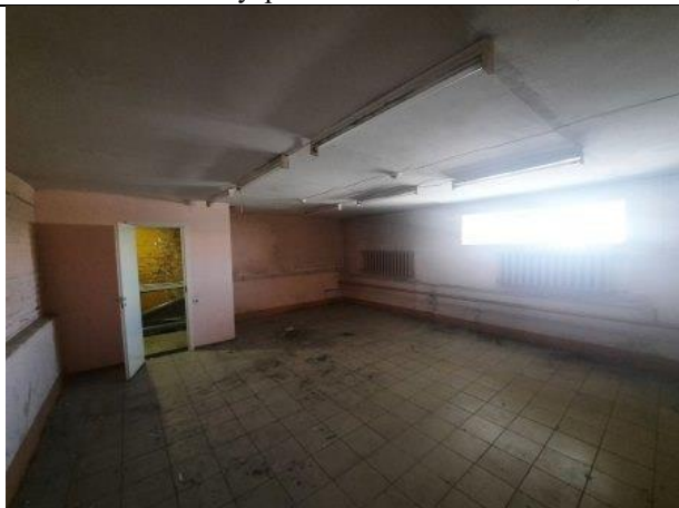
Фото № 11 – Внутреннее состояние помещения
