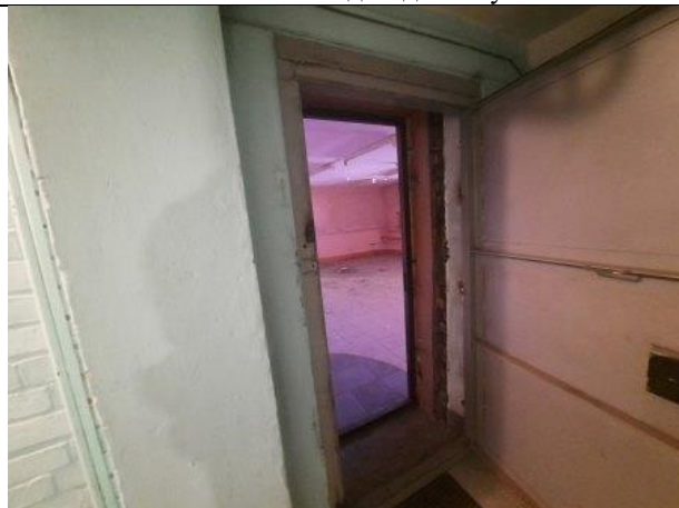
Фото № 6 – Вход в помещение с лестничной клетки № 5
