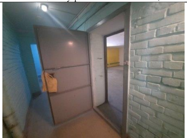
Фото № 18 – Вход в помещение с лестничной клетки № 6
