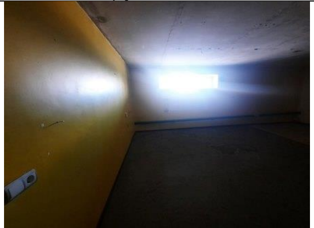
Фото № 24 – Внутреннее состояние помещения
