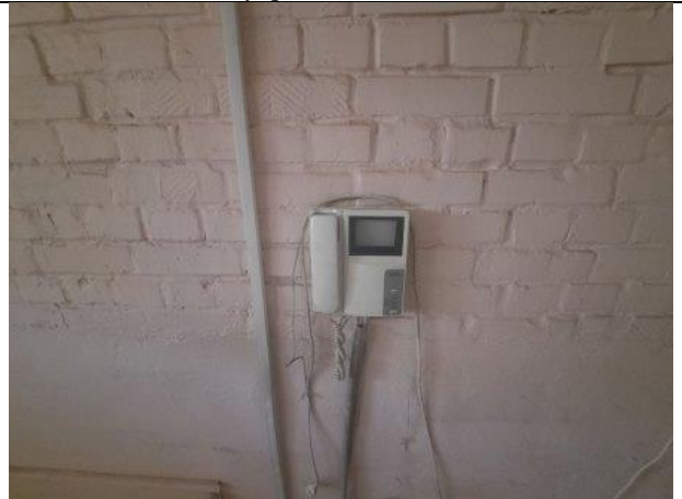
Фото № 16 – Внутреннее состояние помещения
