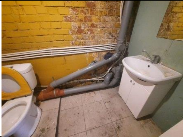
Фото № 13 – Внутреннее состояние помещения
