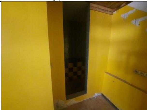
Фото № 27 – Внутреннее состояние помещения
