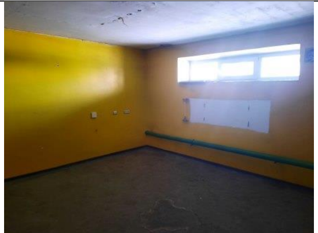
Фото № 22 – Внутреннее состояние помещения
