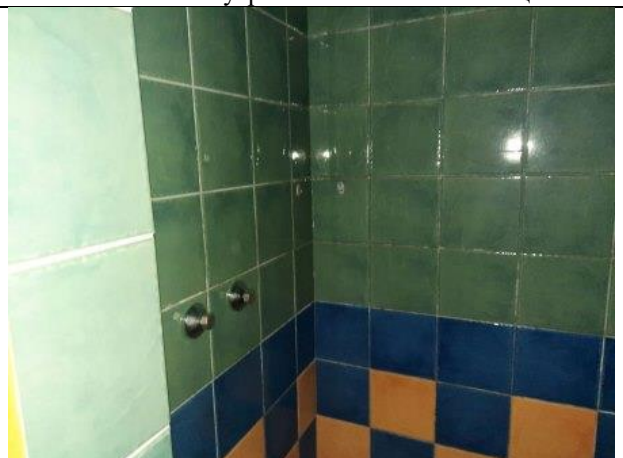
Фото № 26 – Внутреннее состояние помещения
