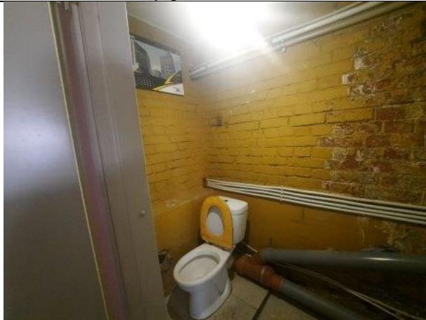
Фото № 15 – Внутреннее состояние помещения
