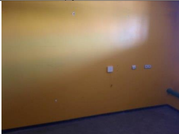
Фото № 23 – Внутреннее состояние помещения
