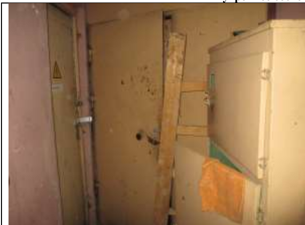
Фото 13. Внутреннее состояние Объекта оценки
