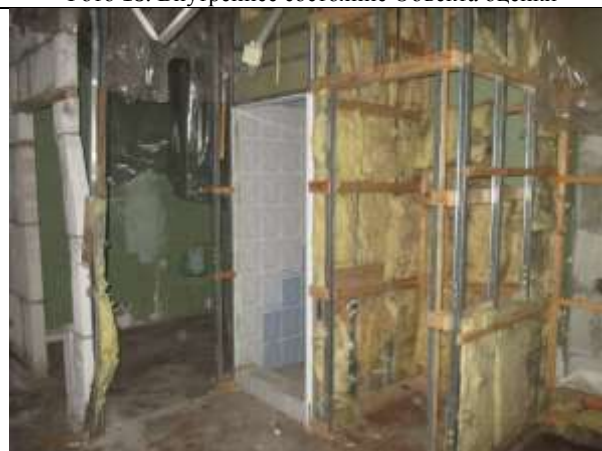
Фото 20. Внутреннее состояние Объекта оценки
