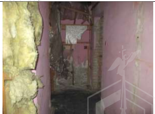
Фото 14. Внутреннее состояние Объекта оценки
