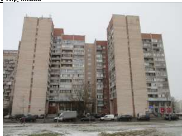
Фото 2. Вид здания, в котором расположен Объект оценки
