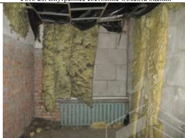
Фото 22. Внутреннее состояние Объекта оценки
