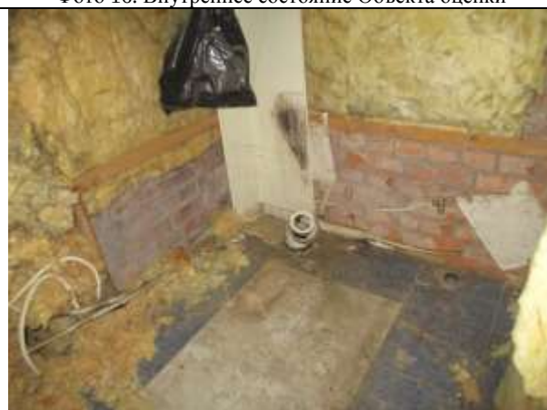
Фото 18. Внутреннее состояние Объекта оценки
