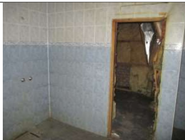
Фото 24. Внутреннее состояние Объекта оценки
