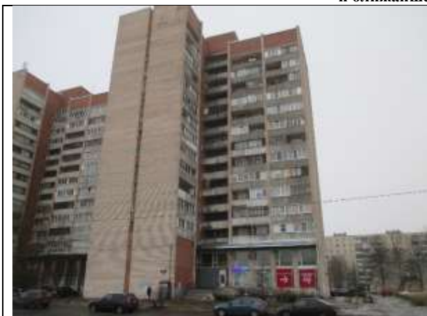
Фото 1. Вид здания, в котором расположен Объект оценки
