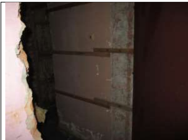
Фото 15. Внутреннее состояние Объекта оценки
