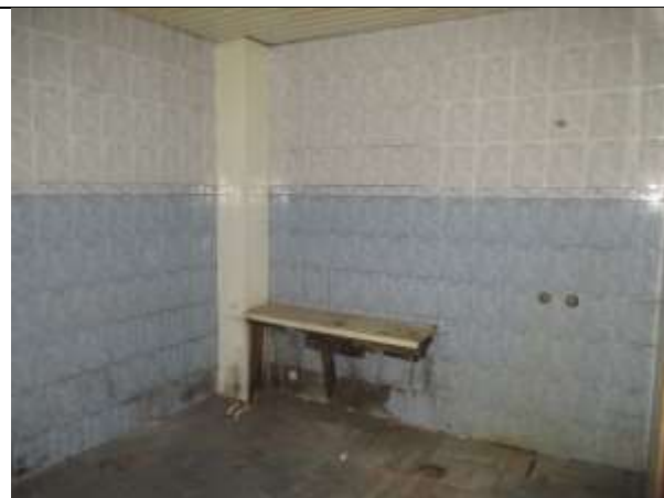
Фото 23. Внутреннее состояние Объекта оценки
