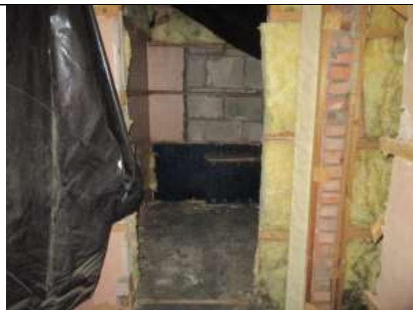
Фото 16. Внутреннее состояние Объекта оценки
