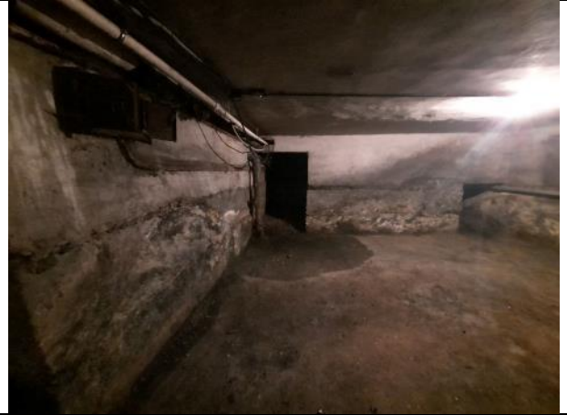
Фото № 40 – Внутреннее состояние помещения
