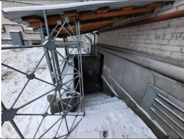
Фото № 7 – Вход в помещение
