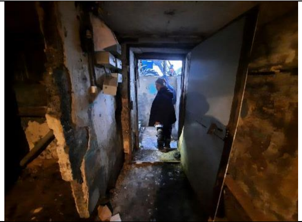
Фото № 8 – Вход в помещение
