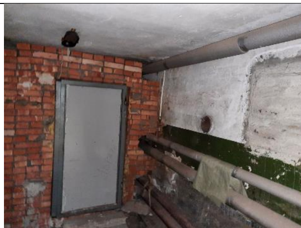
Фото № 32 – Внутреннее состояние помещения
