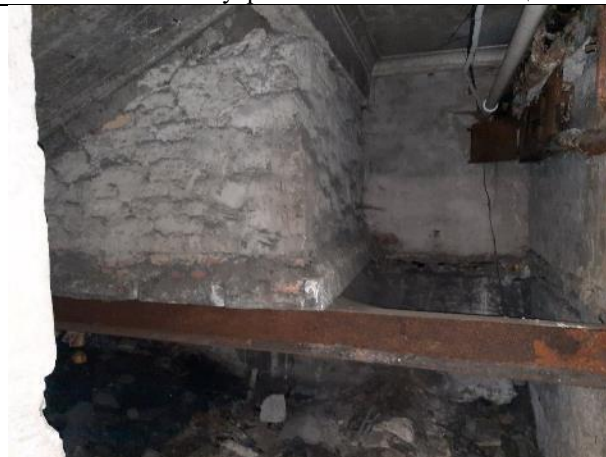
Фото № 34 – Внутреннее состояние помещения
