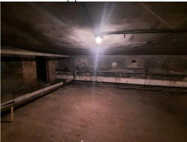
Фото № 29 – Внутреннее состояние помещения
