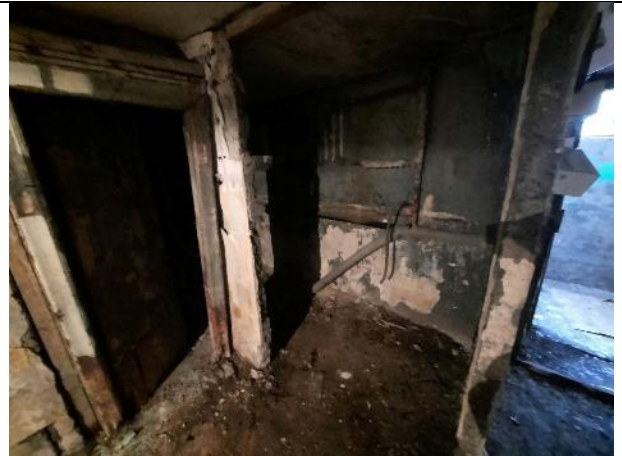
Фото № 10 – Внутреннее состояние помещения
