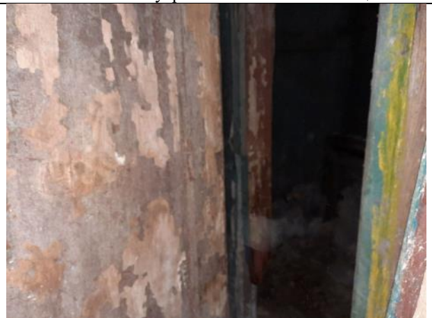
Фото № 12 – Внутреннее состояние помещения
