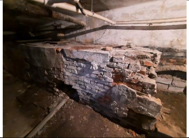
Фото № 16 – Внутреннее состояние помещения
