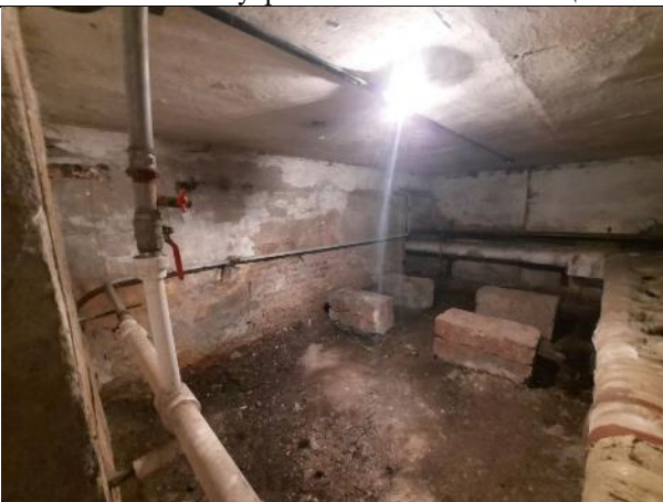
Фото № 21 – Внутреннее состояние помещения
