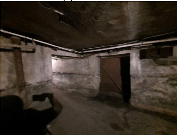
Фото № 43 – Внутреннее состояние помещения
