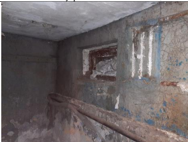
Фото № 11 – Внутреннее состояние помещения
