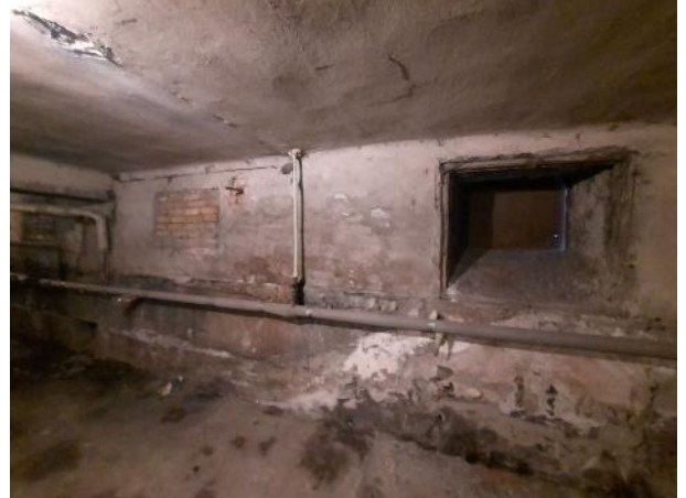
Фото № 26 – Внутреннее состояние помещения
