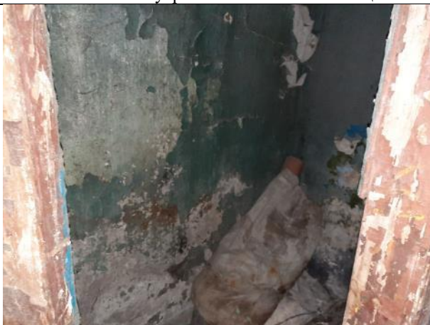
Фото № 13 – Внутреннее состояние помещения
