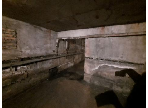
Фото № 42 – Внутреннее состояние помещения
