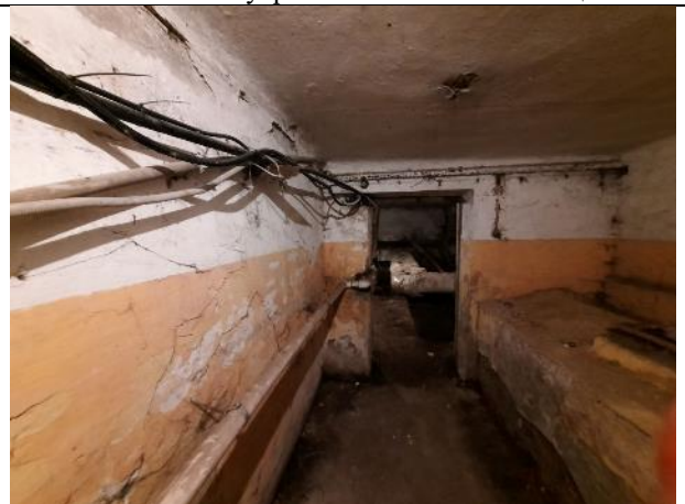
Фото № 20 – Внутреннее состояние помещения
