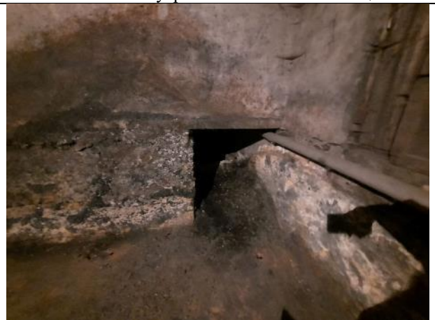
Фото № 44 – Внутреннее состояние помещения
