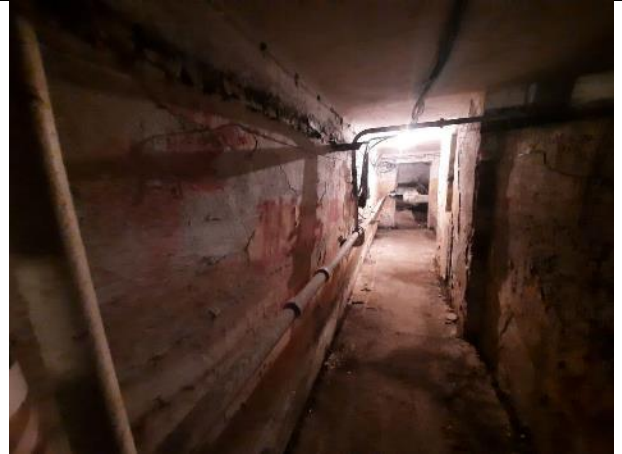
Фото № 18 – Внутреннее состояние помещения
