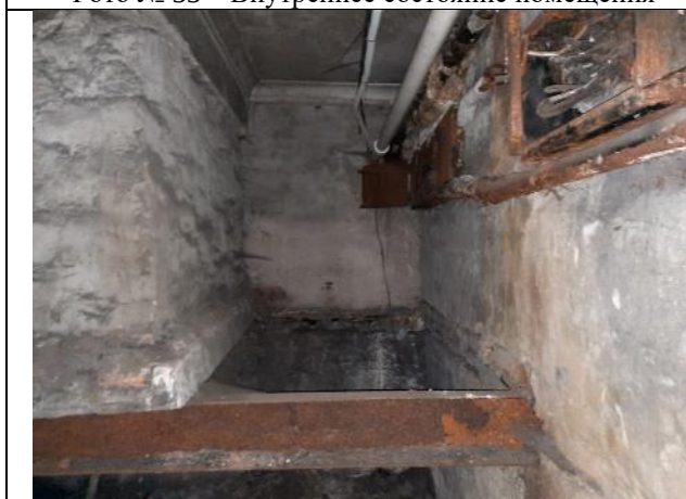
Фото № 35 – Внутреннее состояние помещения
