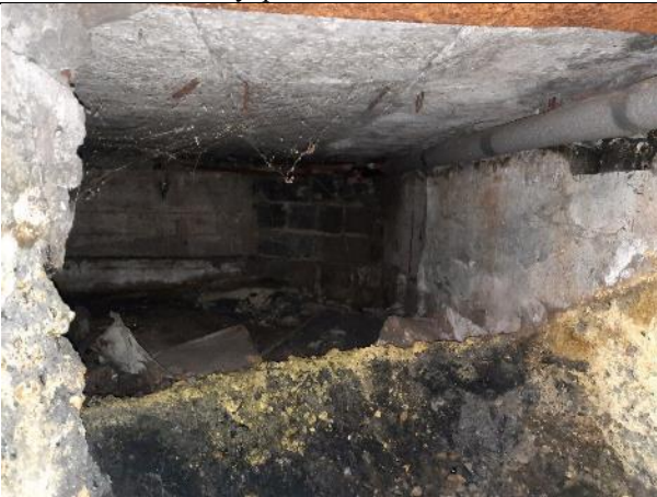
Фото № 45 – Внутреннее состояние помещения
