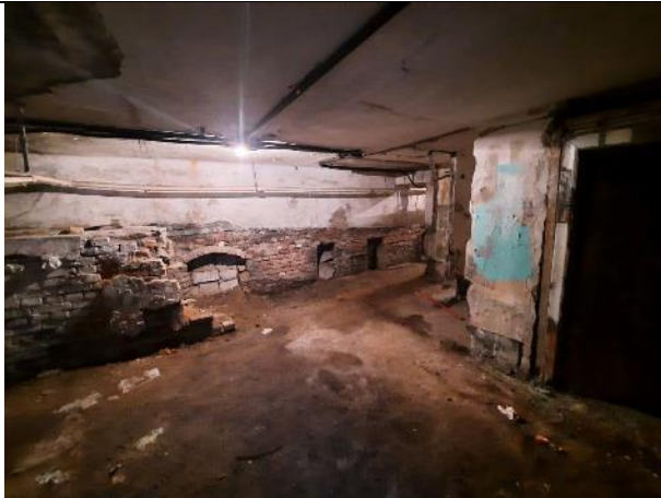
Фото № 9 – Внутреннее состояние помещения
