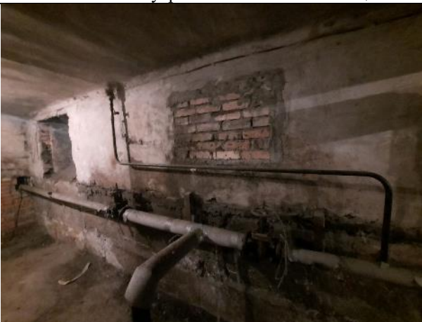
Фото № 27 – Внутреннее состояние помещения
