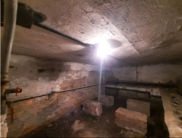
Фото № 23 – Внутреннее состояние помещения
