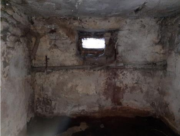
Фото № 17 – Внутреннее состояние помещения
