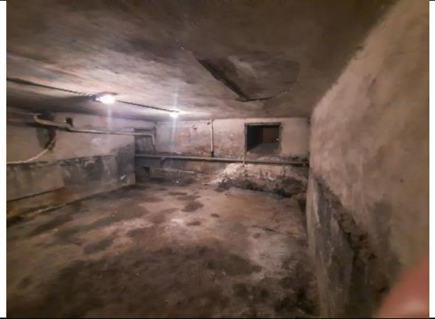
Фото № 24 – Внутреннее состояние помещения
