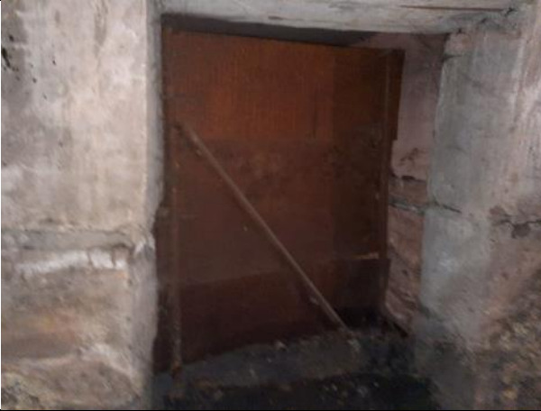
Фото № 39 – Внутреннее состояние помещения
