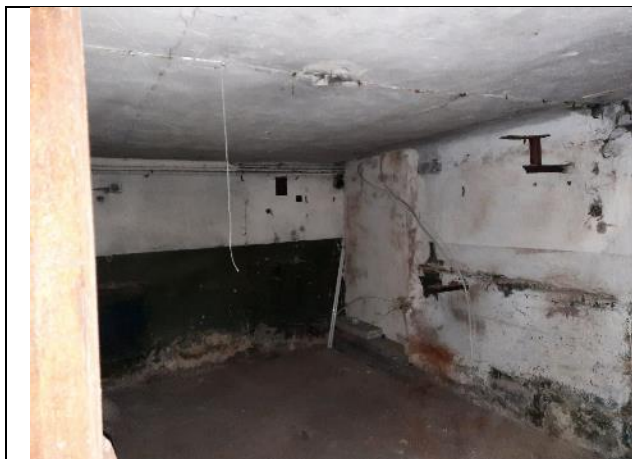
Фото № 31 – Внутреннее состояние помещения
