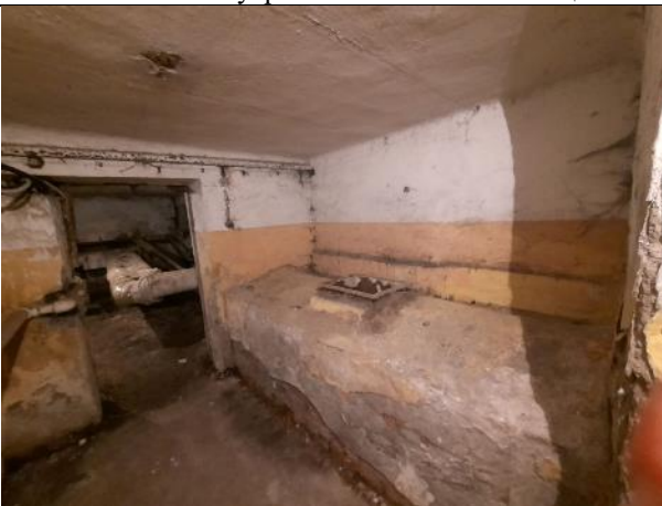
Фото № 19 – Внутреннее состояние помещения
