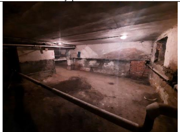
Фото № 28 – Внутреннее состояние помещения
