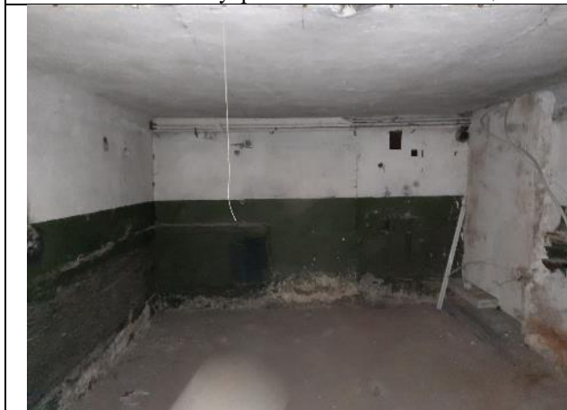
Фото № 33 – Внутреннее состояние помещения
