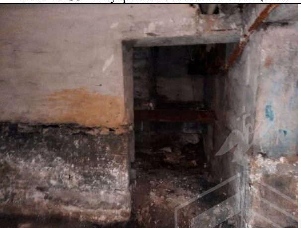
Фото № 38 – Внутреннее состояние помещения
