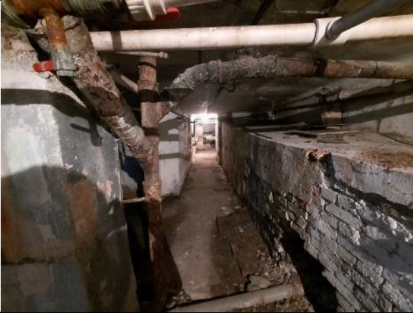
Фото № 15 – Внутреннее состояние помещения
