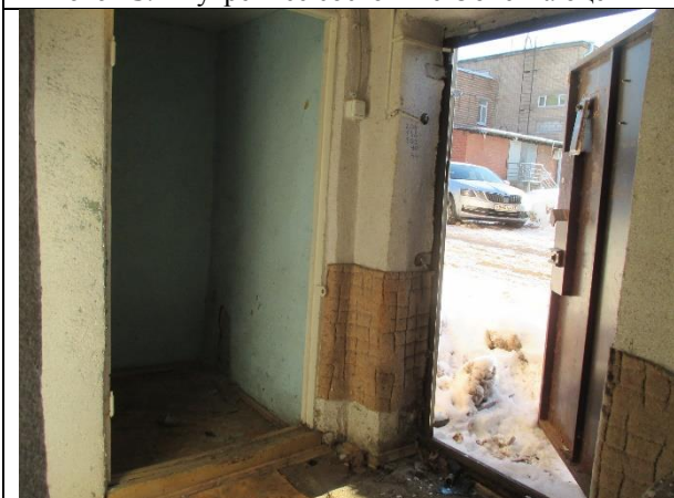
Фото 15. Внутреннее состояние Объекта оценки
