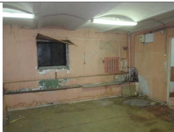
Фото 18. Внутреннее состояние Объекта оценки
