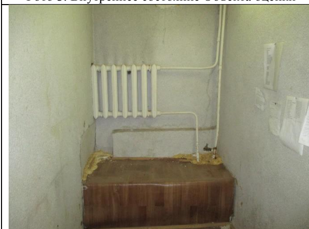
Фото 11. Внутреннее состояние Объекта оценки
