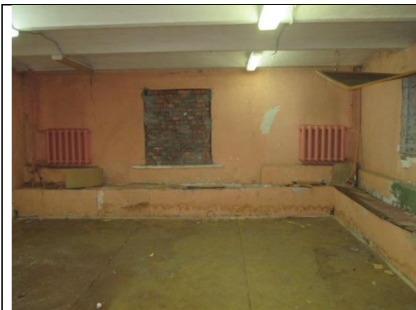
Фото 17. Внутреннее состояние Объекта оценки
