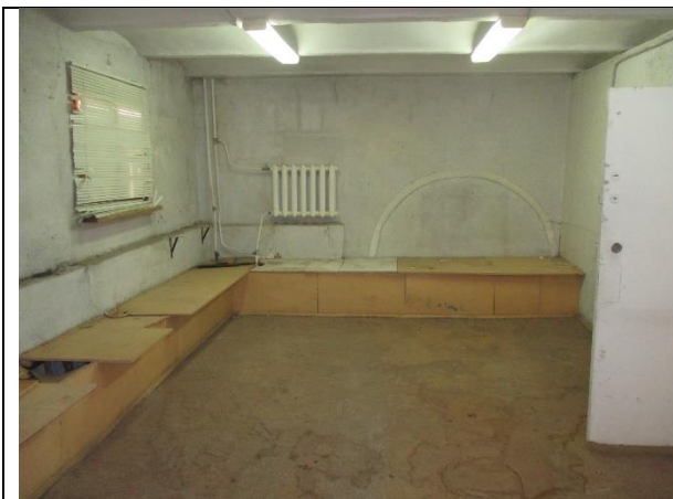
Фото 9. Внутреннее состояние Объекта оценки
