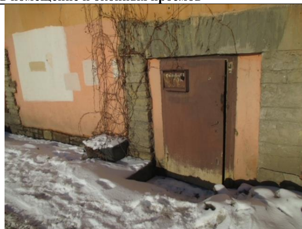
Фото 4. Вход Объекта оценки
