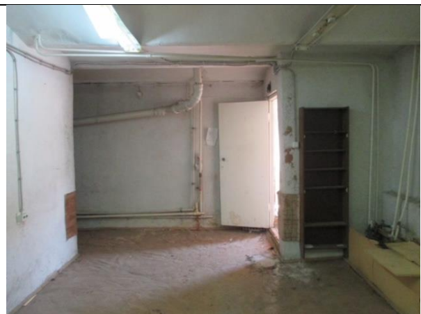
Фото 10. Внутреннее состояние Объекта оценки
