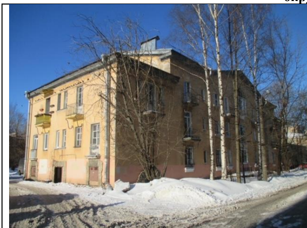
Фото 1. Вид здания, в котором расположен Объект оценки
