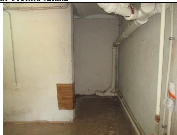
Фото 8. Внутреннее состояние Объекта оценки
