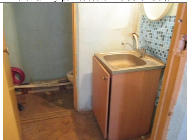
Фото 20. Внутреннее состояние Объекта оценки
