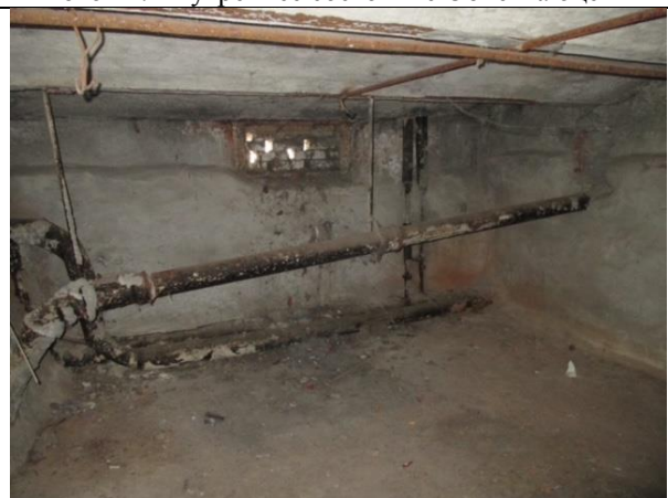
Фото 14. Внутреннее состояние Объекта оценки
