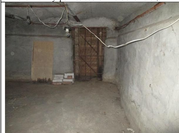
Фото 13. Внутреннее состояние Объекта оценки
