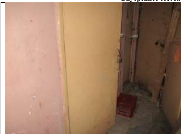
Фото 9. Внутреннее состояние Объекта оценки
