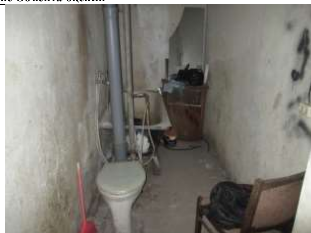
Фото 10. Внутреннее состояние Объекта оценки
