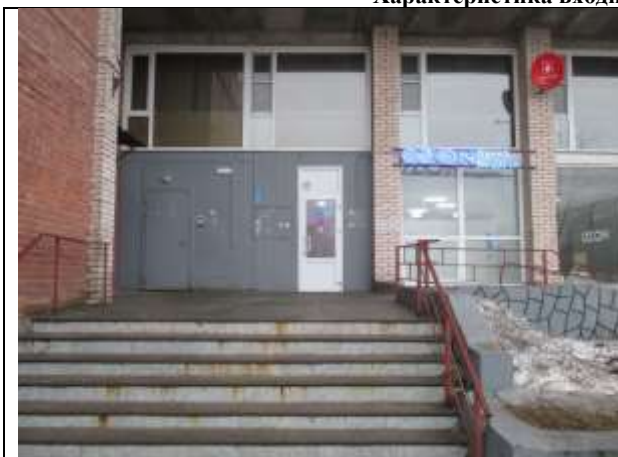
Фото 5. Общий вход с улицы
