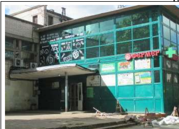
Фото 1. Вид здания, в котором расположен Объект оценки, со двора
