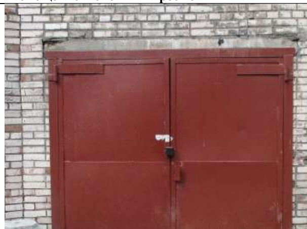
Фото 4. Отдельный вход со двора Объекта оценки
