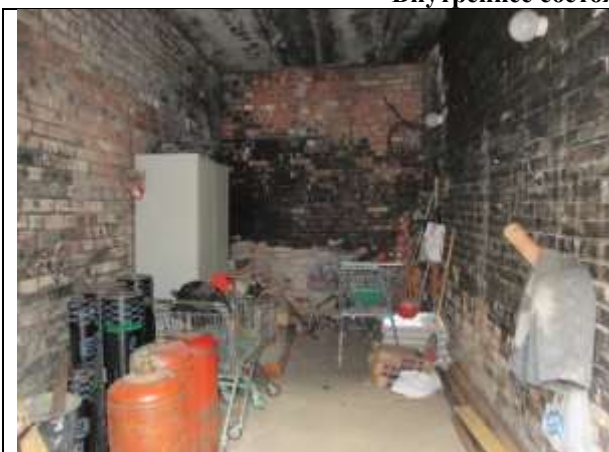
Фото 5. Внутреннее состояние Объекта оценки
