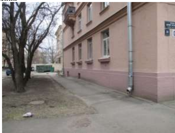
Фото 2. Вид здания, в котором расположен Объект оценки
