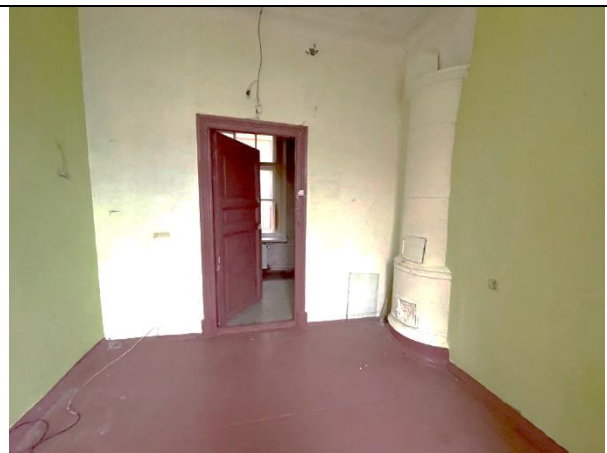
Фото 54. Типичное состояние Объекта оценки
