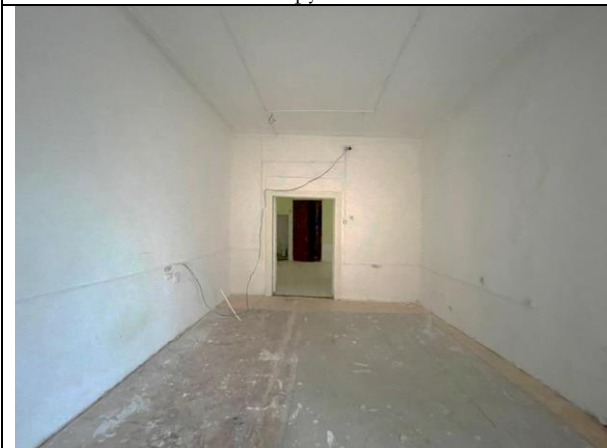
Фото 39. Типичное состояние Объекта оценки
