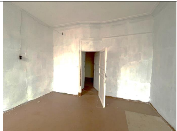
Фото 64. Типичное состояние Объекта оценки
