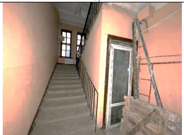
Фото 26. Лестничный проём Объекта оценки
