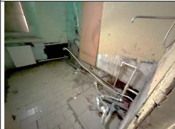
Фото 55. Типичное состояние Объекта оценки
