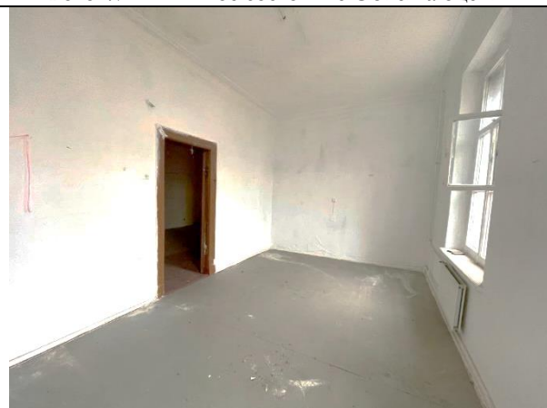
Фото 49. Типичное состояние Объекта оценки
