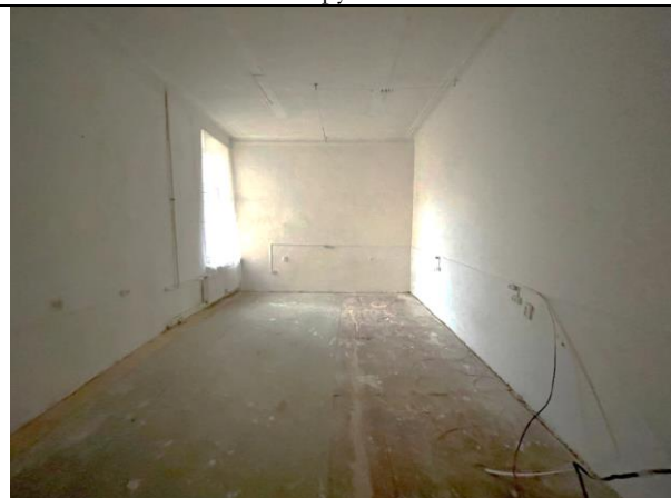
Фото 40. Типичное состояние Объекта оценки
