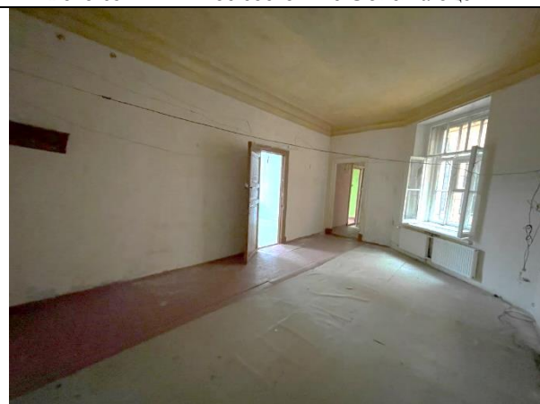
Фото 67. Типичное состояние Объекта оценки
