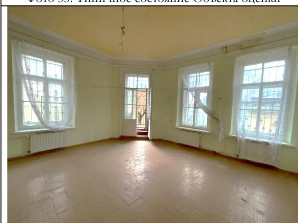
Фото 35. Типичное состояние Объекта оценки
