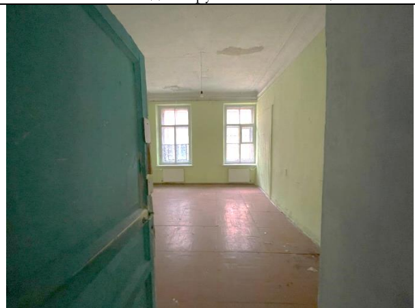
Фото 32. Типичное состояние Объекта оценки
