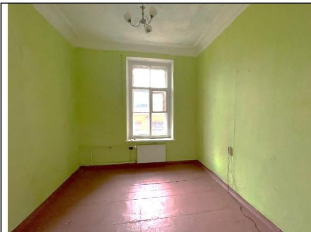
Фото 53. Типичное состояние Объекта оценки
