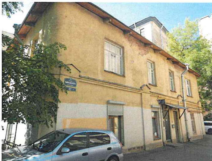
Фото №3 (вход отдельный со двора)
