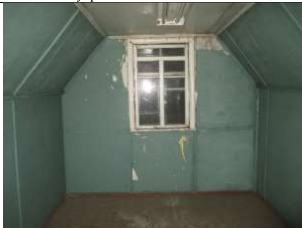
Фото 30. Внутреннее состояние Объекта оценки
