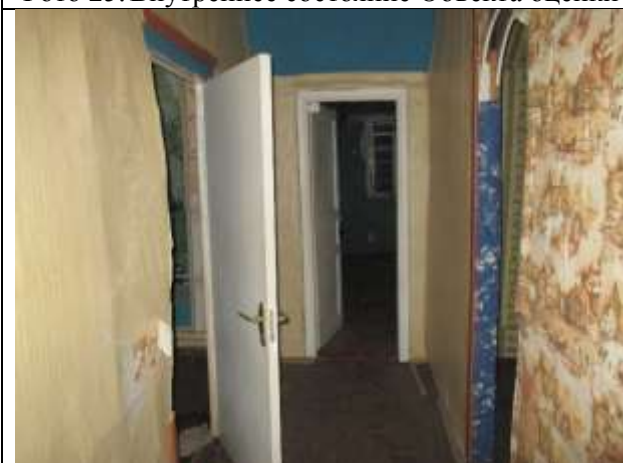
Фото 27. Внутреннее состояние Объекта оценки
