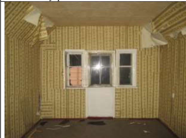
Фото 29. Внутреннее состояние Объекта оценки
