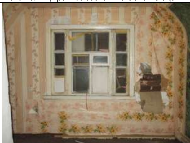
Фото 28. Внутреннее состояние Объекта оценки
