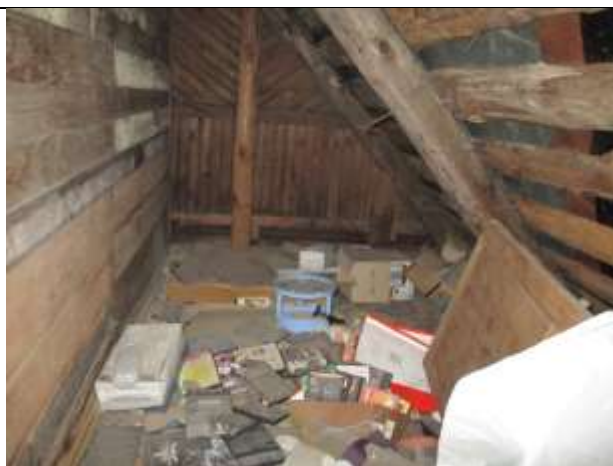
Фото 26. Внутреннее состояние Объекта оценки
