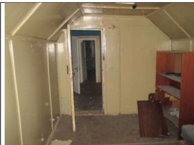
Фото 25. Внутреннее состояние Объекта оценки
