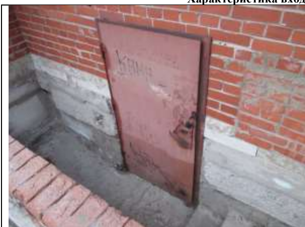
Фото 5. 1 отдельный вход с улицы
