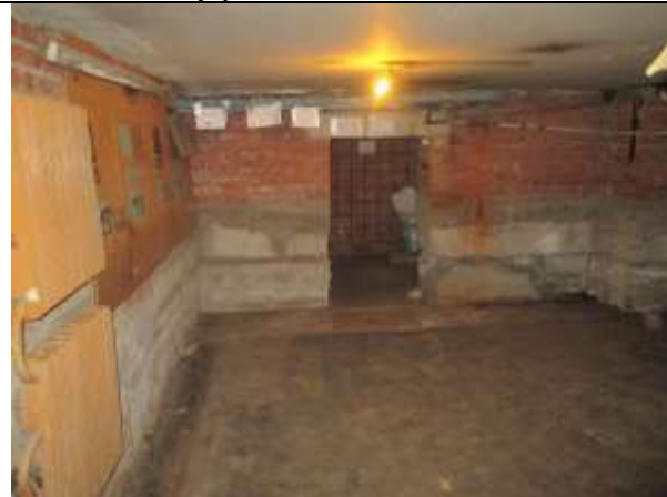
Фото 9. Внутреннее состояние Объекта оценки
