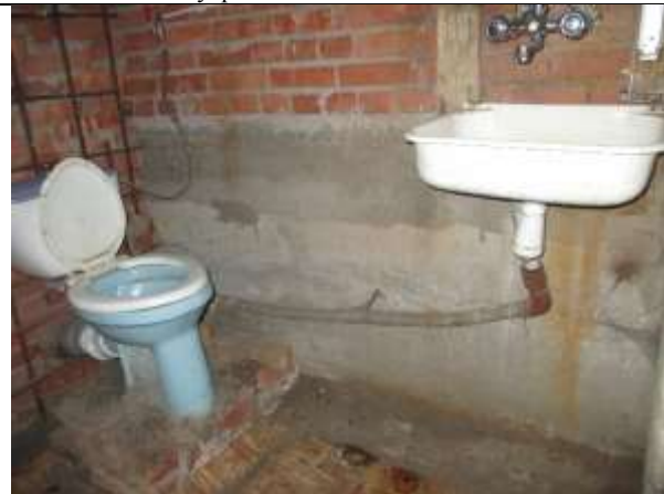
Фото 11. Внутреннее состояние Объекта оценки
