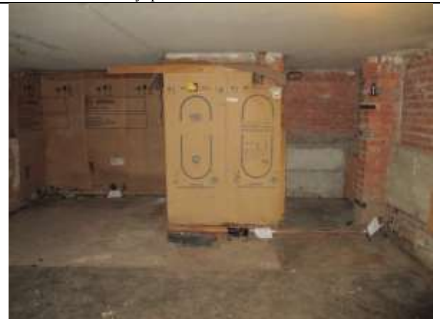
Фото 12. Внутреннее состояние Объекта оценки
