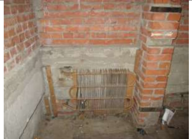
Фото 8. Внутреннее состояние Объекта оценки
