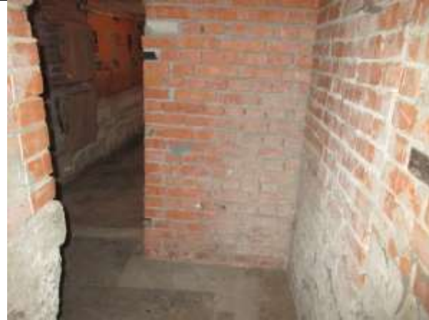
Фото 7. Внутреннее состояние Объекта оценки
