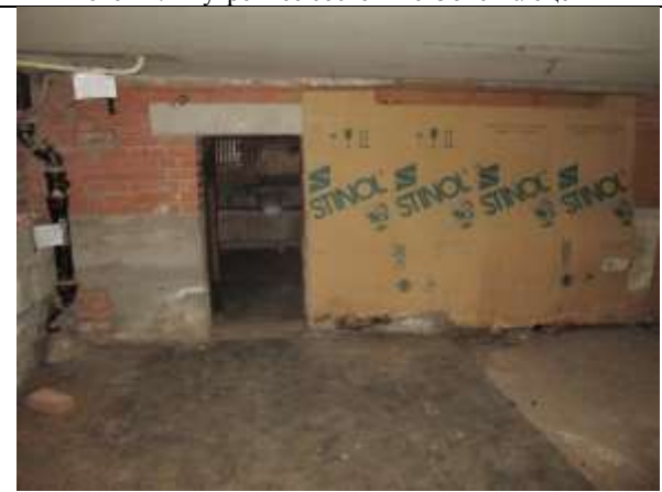
Фото 13. Внутреннее состояние Объекта оценки
