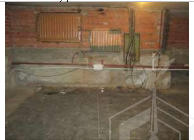
Фото 14. Внутреннее состояние Объекта оценки
