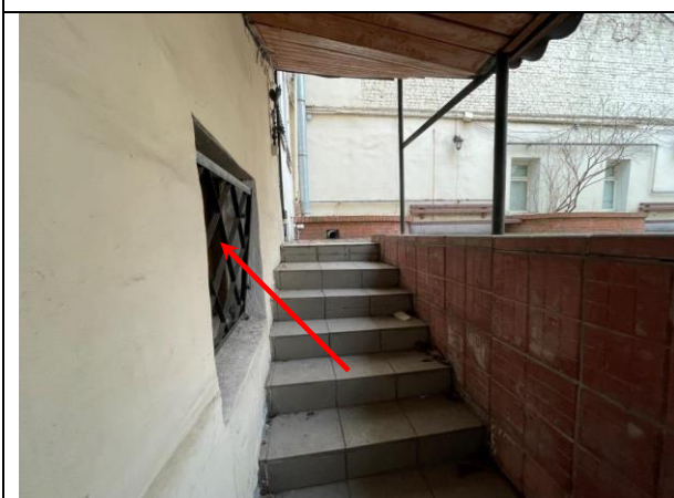
Фото 17. Входная и оконная группа Объекта оценки
