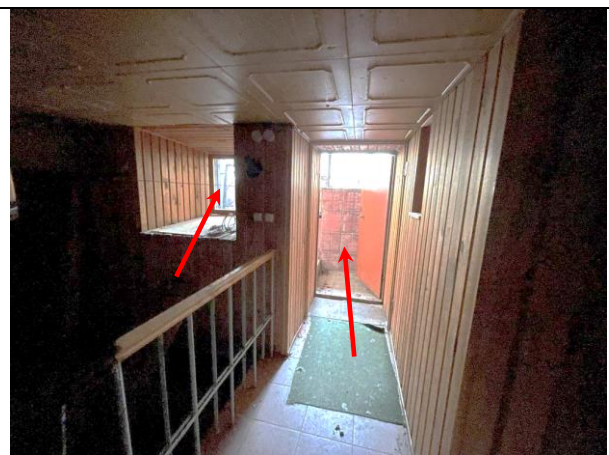
Фото 20. Входная и оконная группа Объекта оценки
