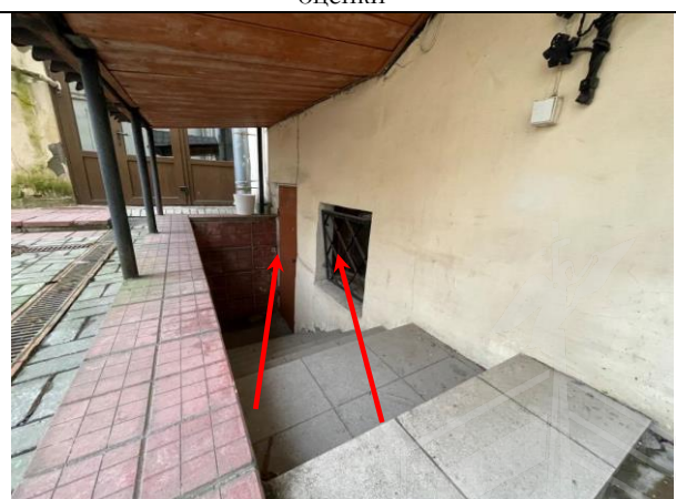
Фото 18. Входная и оконная группа Объекта оценки
