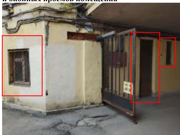
Фото 4. Отдельный вход со двора и окна Объекта оценки
