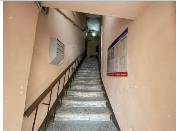
Фото 17. Лестничный проём Объекта оценки
