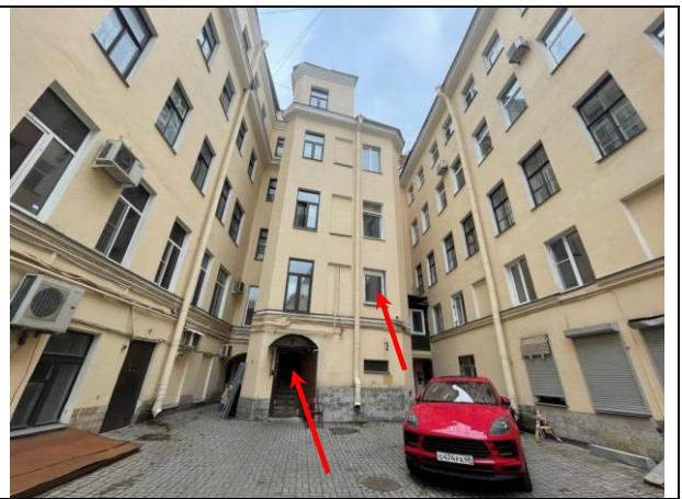
Фото 16. Вид здания расположения Объекта оценки, входная группа Объекта оценки (1 общий вход со двора), оконная группа Объекта оценки
