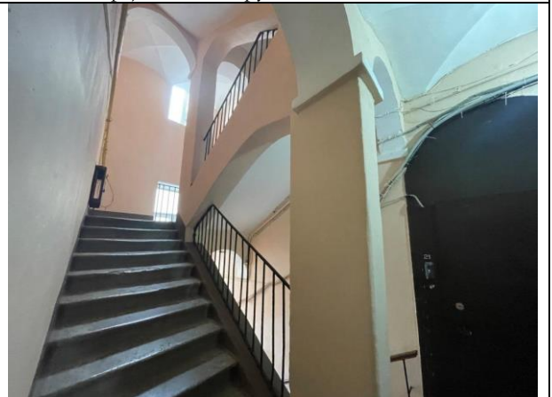
Фото 18. Лестничный проём Объекта оценки
