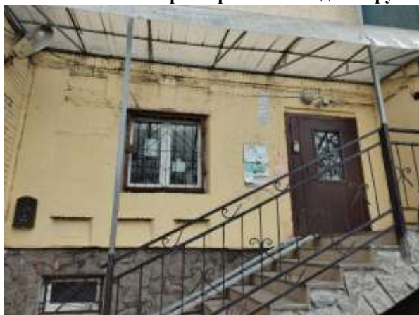
Фото 3. Общий вход со двора и окно Объекта оценки
