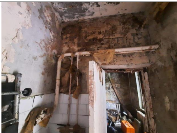
Фото № 15. Внутреннее состояние здания
