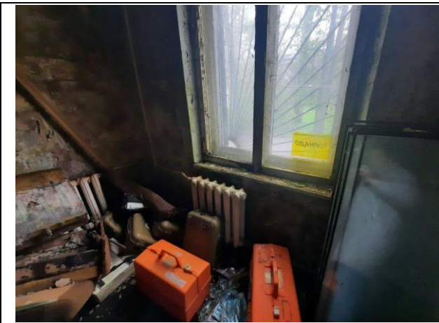
Фото № 17. Внутреннее состояние здания
