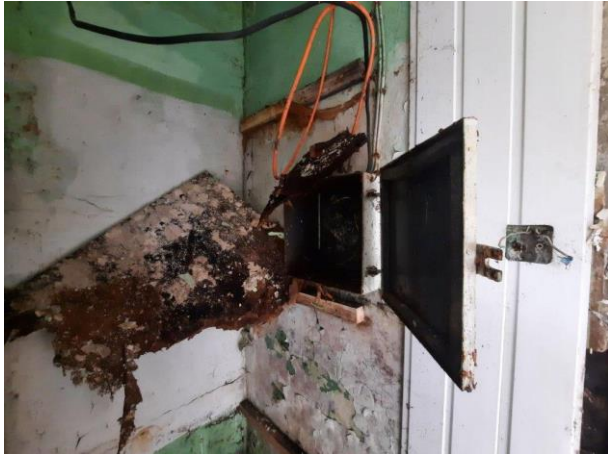
Фото № 11. Внутреннее состояние здания
