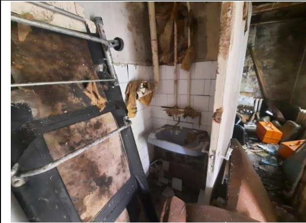
Фото № 19. Внутреннее состояние здания
