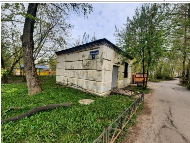
Фото № 7. Внешний вид здания и земельного участка
