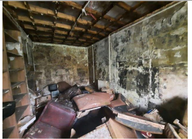
Фото № 20. Внутреннее состояние здания
