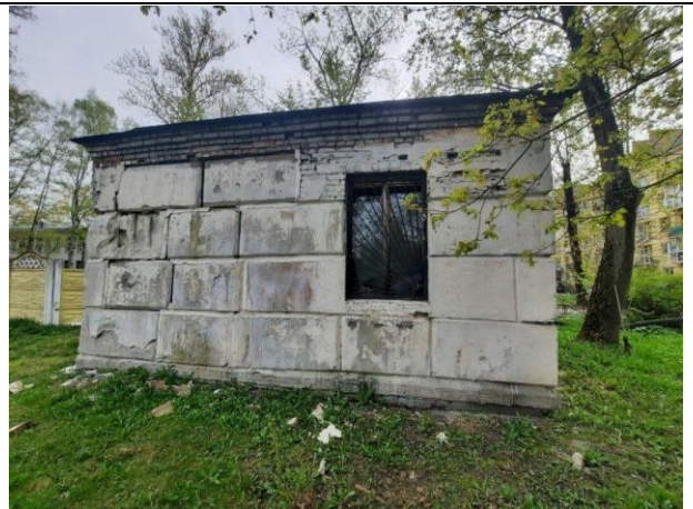
Фото № 6. Внешний вид здания и земельного участка
