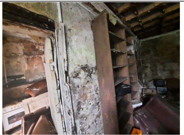
Фото № 18. Внутреннее состояние здания
