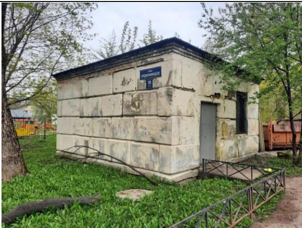
Фото № 5. Внешний вид здания и земельного участка
