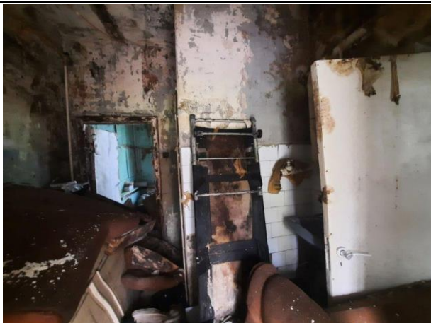
Фото № 13. Внутреннее состояние здания
