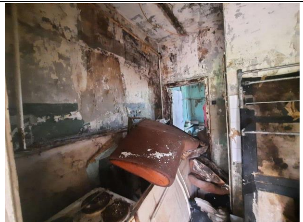
Фото № 14. Внутреннее состояние здания
