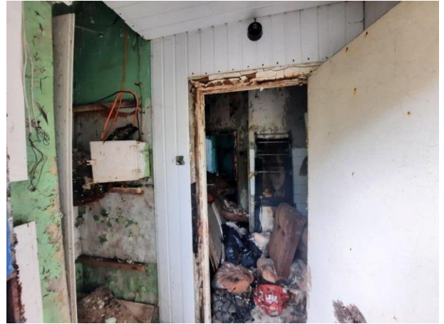
Фото № 12. Внутреннее состояние здания
