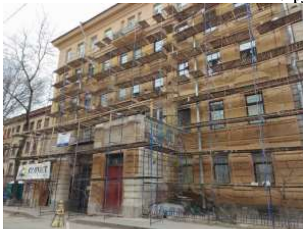
Фото 1. Вид здания, в котором расположен Объект оценки
