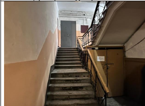
Фото 11. Лестничный проём Объекта оценки
