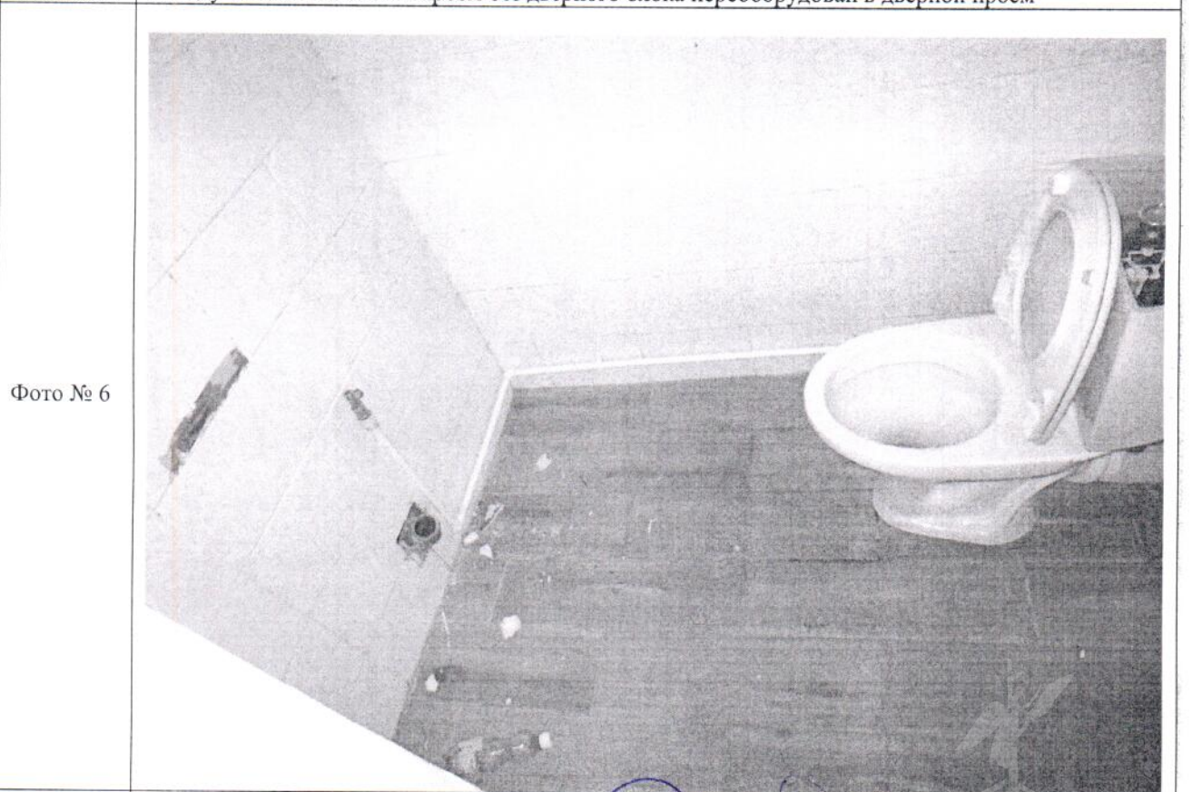
Описание: Внутри ч.п. 1 в ч.п. 3 Объекта демонтировано сантехническое оборудование (раковина)
