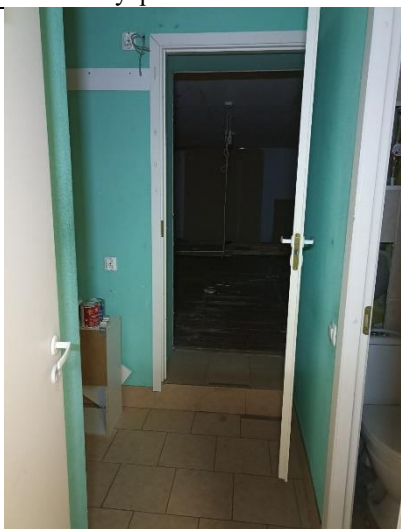
Фото № 23 – Внутреннее состояние помещения
