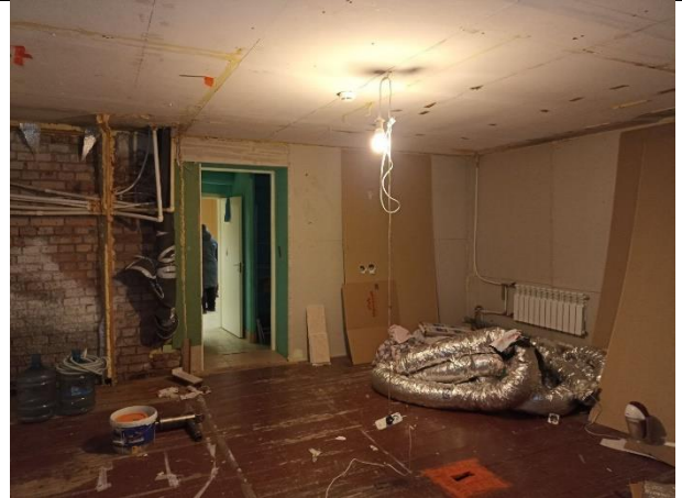
Фото № 16 – Внутреннее состояние помещения
