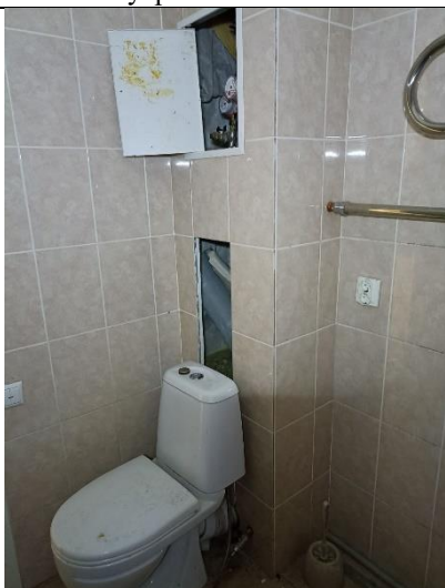
Фото № 21 – Внутреннее состояние помещения
