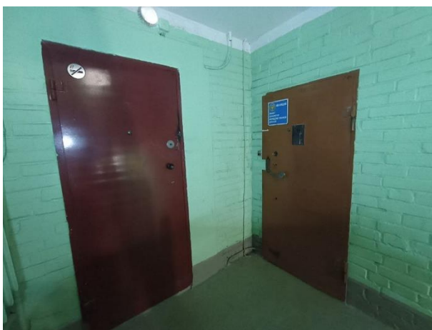
Фото № 9 – Вход в помещение
