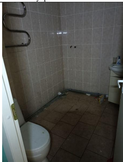
Фото № 22 – Внутреннее состояние помещения
