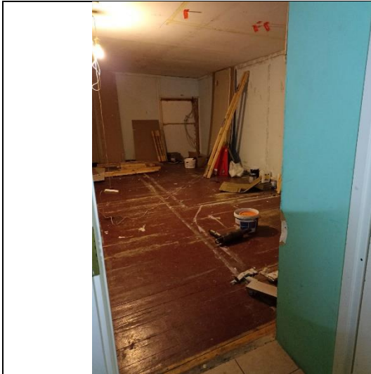
Фото № 13 – Внутреннее состояние помещения
