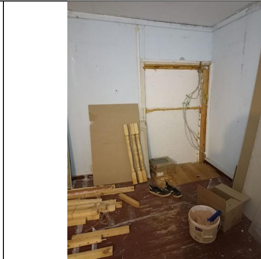
Фото № 14 – Внутреннее состояние помещения
