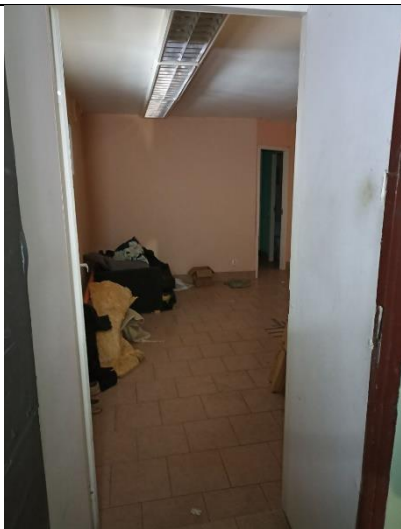
Фото № 19 – Внутреннее состояние помещения
