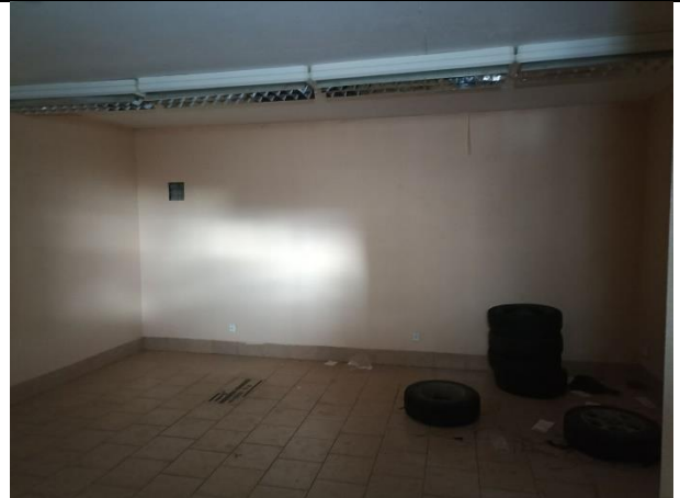
Фото № 18 – Внутреннее состояние помещения
