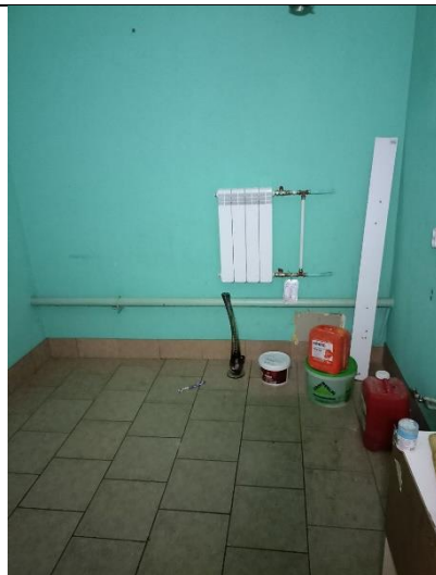
Фото № 20 – Внутреннее состояние помещения
