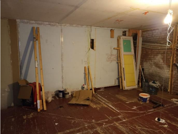
Фото № 15 – Внутреннее состояние помещения
