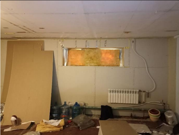
Фото № 17 – Внутреннее состояние помещения
