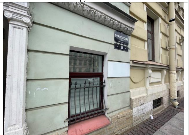
Фото 10. Адрес Объекта оценки
