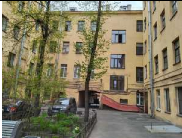
Фото 7 Фасад здания со двора
