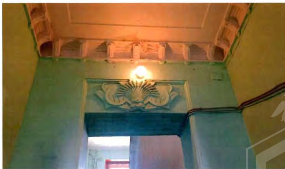
14. Интерьер. Пространство ЛК-1.
