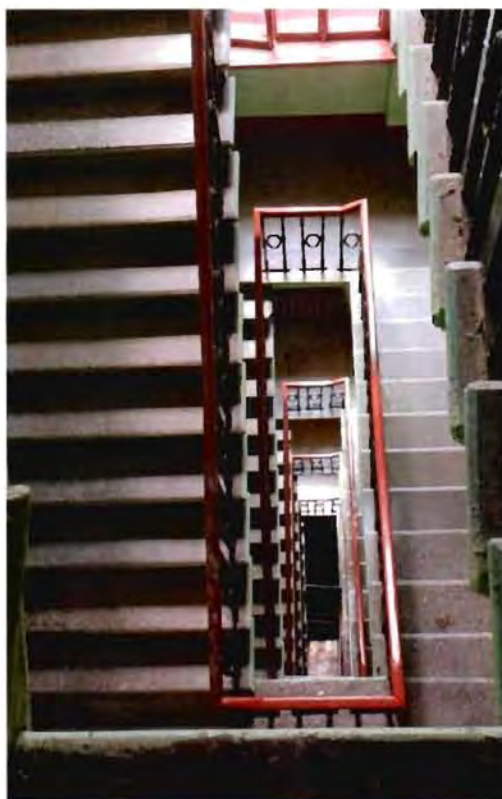
16. Интерьер. Пространство ЛК-9.
