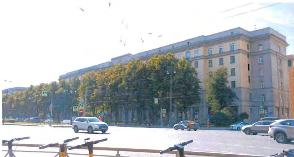
1. Общий вид. Восточный фасад северного флигеля.
