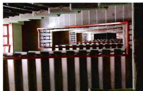
16. Интерьер. Пространство ЛК-9.
