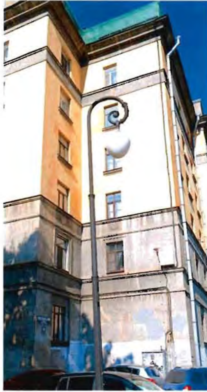
7. Фрагмент. Северный фасад южного флигеля.
