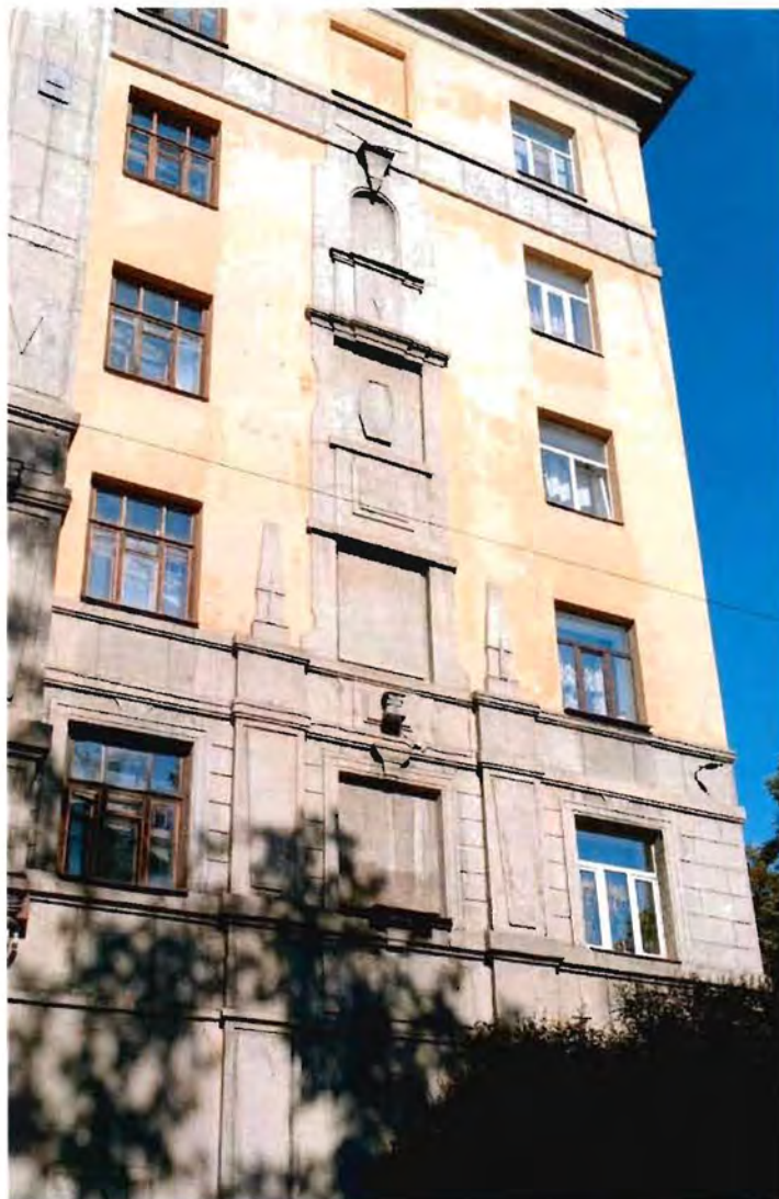
13. Фрагмент. Северный фасад северного флигеля.
