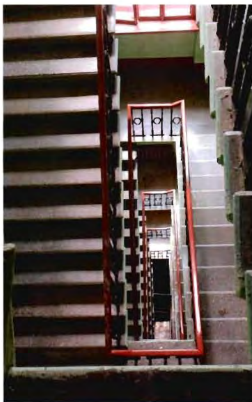
16. Интерьер. Пространство ЛК-9.
