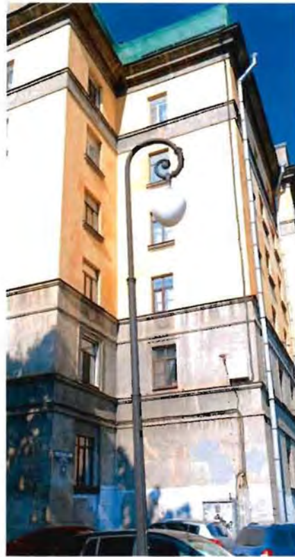
7. Фрагмент. Северный фасад южного флигеля.
