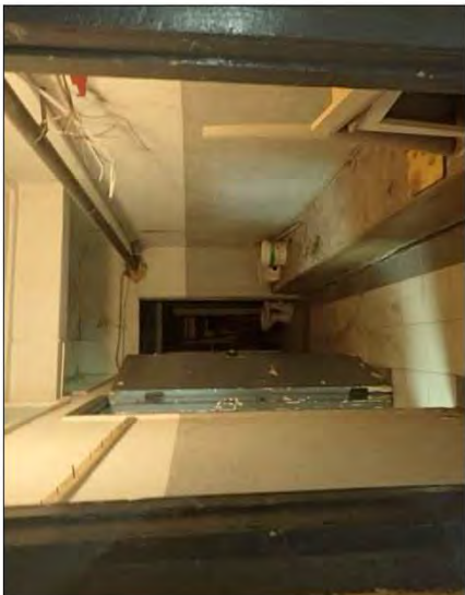
Описание: Вид внутри Объекта
