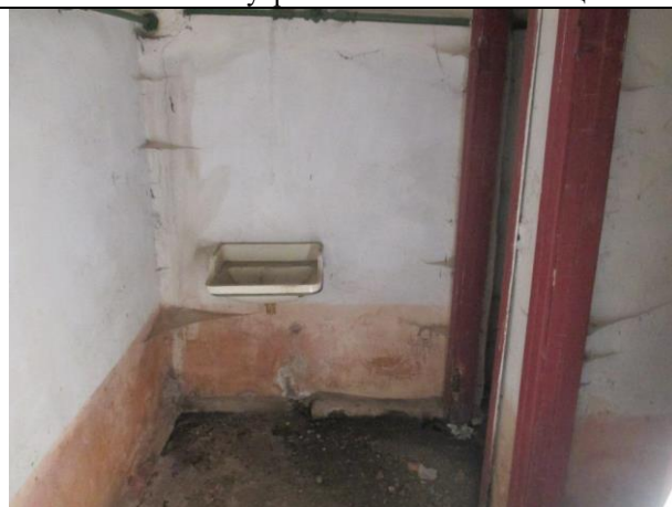
Фото № 26 – Внутреннее состояние помещения
