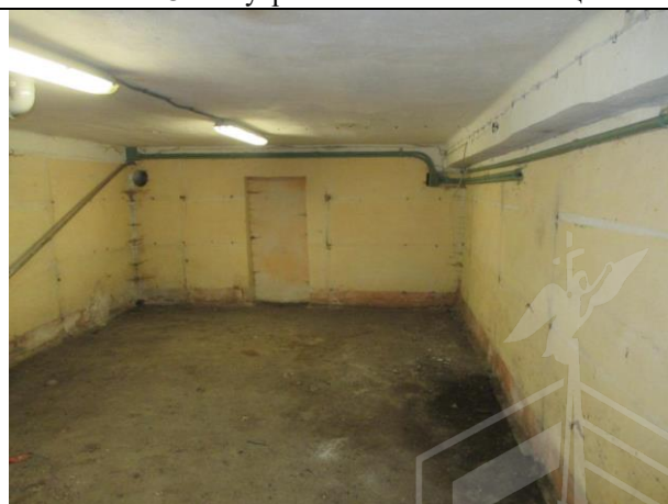
Фото № 30 – Внутреннее состояние помещения
