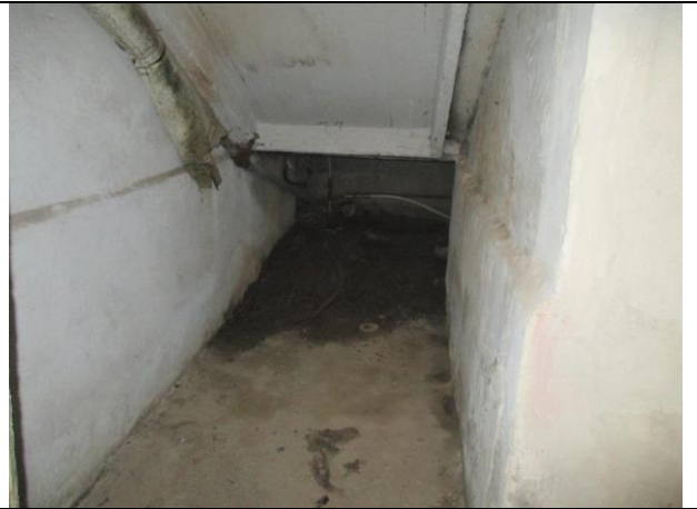
Фото № 16 – Внутреннее состояние помещения
