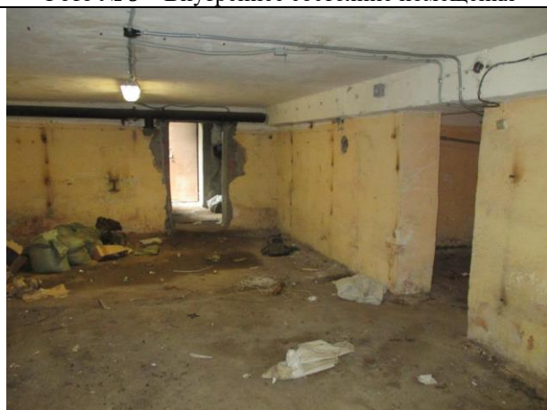
Фото № 11 – Внутреннее состояние помещения
