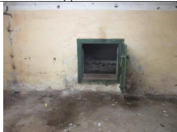
Фото № 10 – Внутреннее состояние помещения
