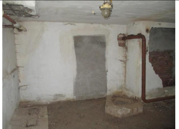
Фото № 18 – Внутреннее состояние помещения
