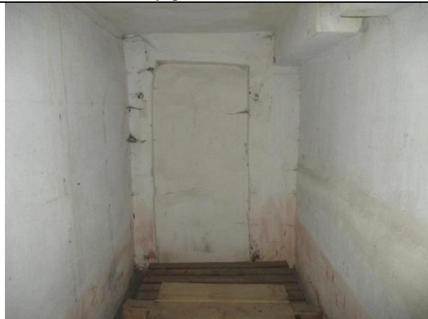
Фото № 21 – Внутреннее состояние помещения
