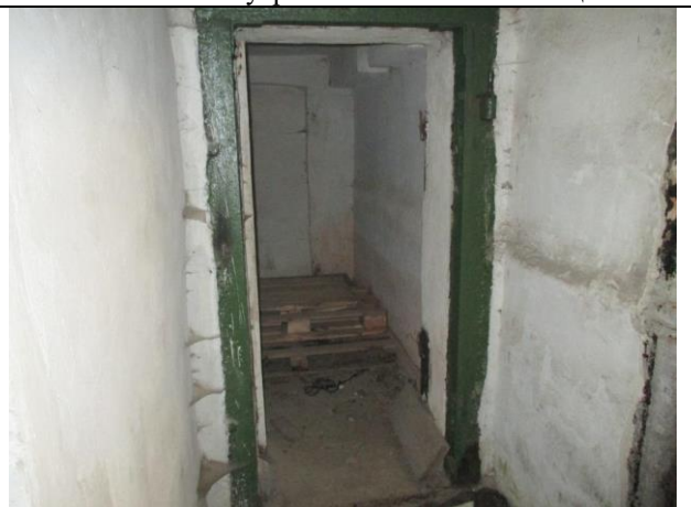
Фото № 20 – Внутреннее состояние помещения
