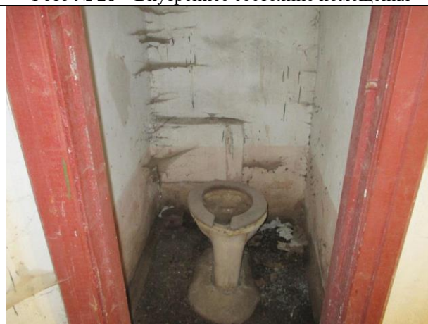
Фото № 28 – Внутреннее состояние помещения
