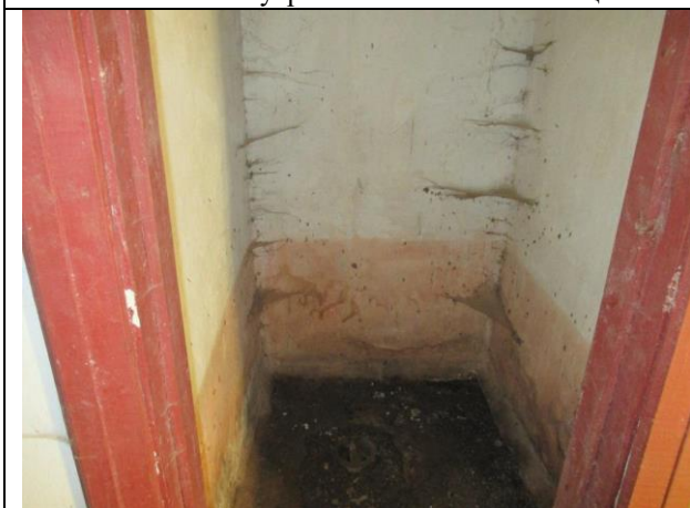
Фото № 29 – Внутреннее состояние помещения
