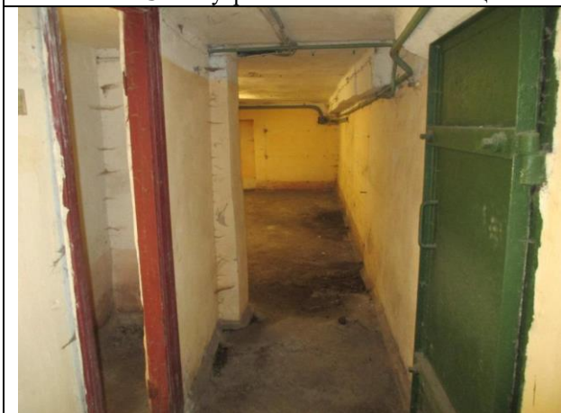
Фото № 25 – Внутреннее состояние помещения
