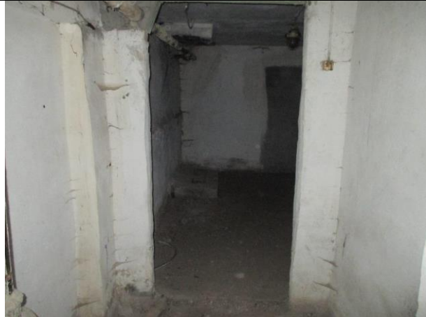
Фото № 17 – Внутреннее состояние помещения
