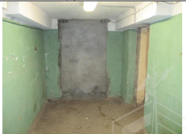
Фото № 22 – Внутреннее состояние помещения
