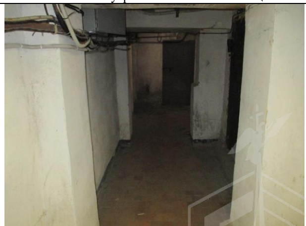
Фото № 14 – Внутреннее состояние помещения
