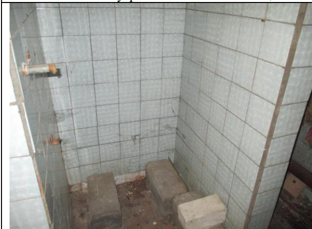
Фото № 25 – Внутреннее состояние помещения
