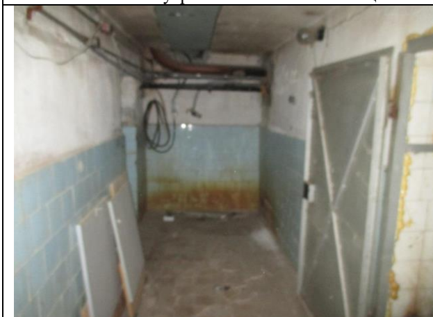
Фото № 13 – Внутреннее состояние помещения
