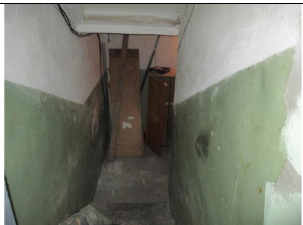
Фото № 8 – Внутреннее состояние помещения
