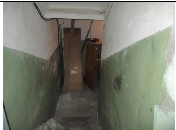
Фото № 8 – Внутреннее состояние помещения
