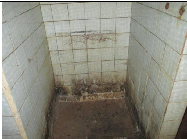
Фото № 24 – Внутреннее состояние помещения
