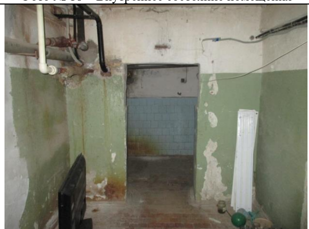
Фото № 12 – Внутреннее состояние помещения
