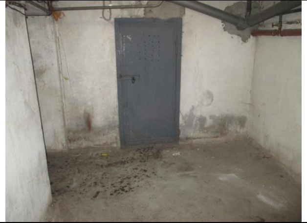
Фото № 16 – Внутреннее состояние помещения
