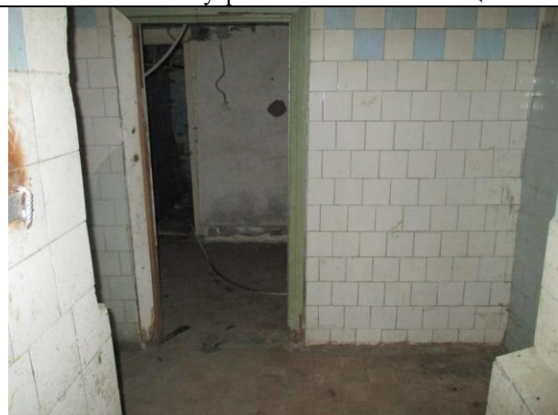
Фото № 26 – Внутреннее состояние помещения
