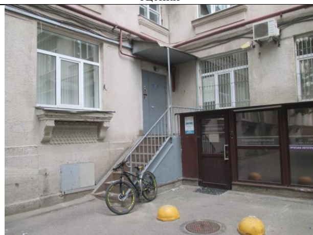
Фото № 5 – Общий вход в помещение
