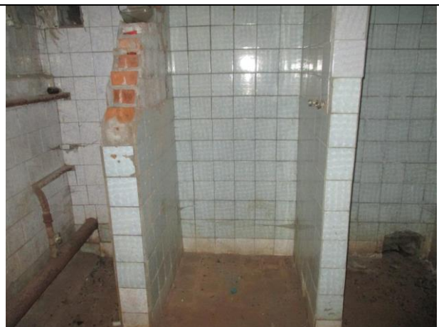
Фото № 32 – Внутреннее состояние помещения
