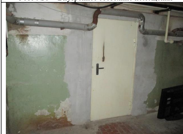
Фото № 11 – Внутреннее состояние помещения
