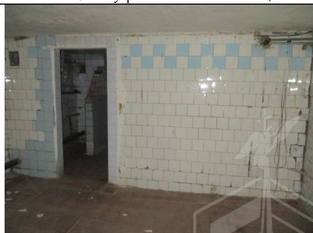
Фото № 30 – Внутреннее состояние помещения
