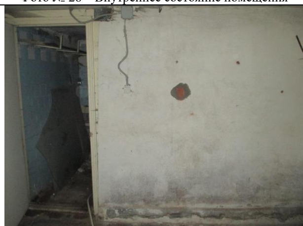
Фото № 28 – Внутреннее состояние помещения
