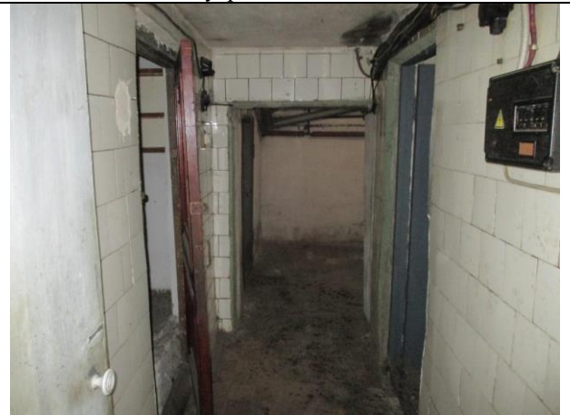
Фото № 20 – Внутреннее состояние помещения
