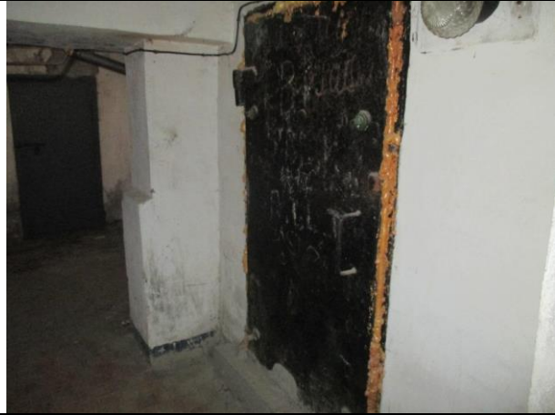
Фото № 15 – Внутреннее состояние помещения
