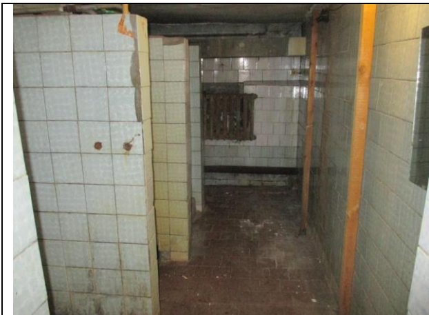
Фото № 23 – Внутреннее состояние помещения
