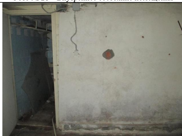
Фото № 28 – Внутреннее состояние помещения
