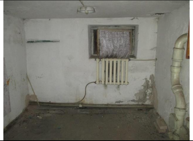
Фото № 18 – Внутреннее состояние помещения
