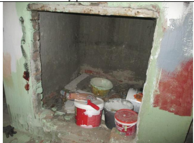
Фото № 10 – Внутреннее состояние помещения
