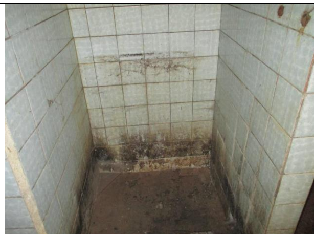
Фото № 24 – Внутреннее состояние помещения
