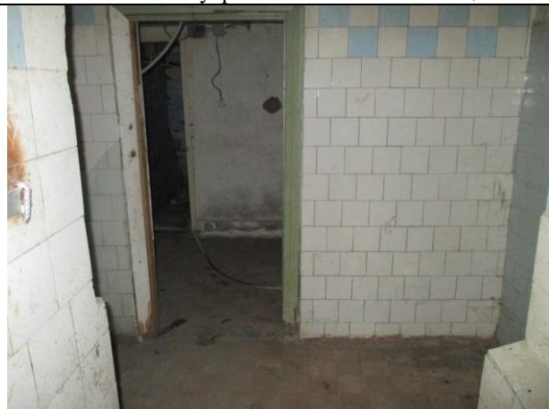
Фото № 26 – Внутреннее состояние помещения
