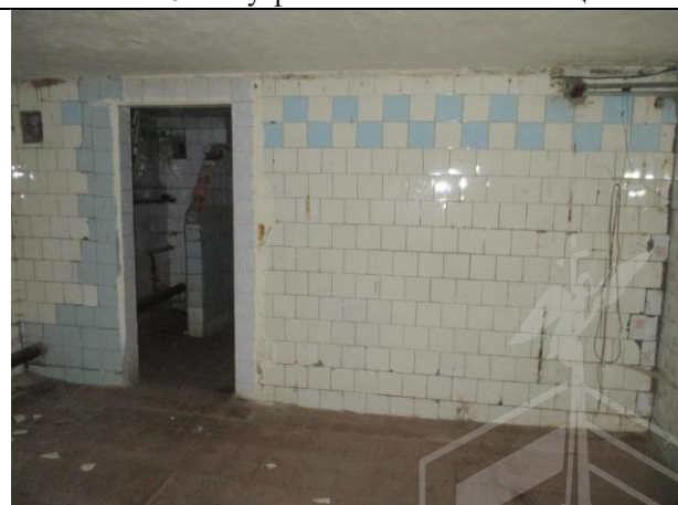
Фото № 30 – Внутреннее состояние помещения
