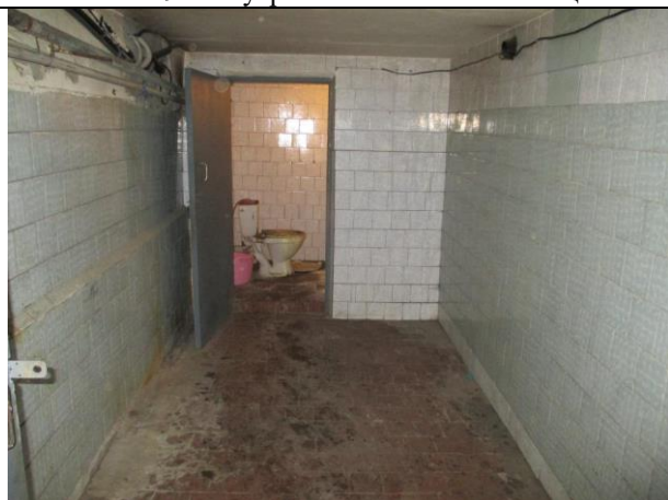
Фото № 21 – Внутреннее состояние помещения
