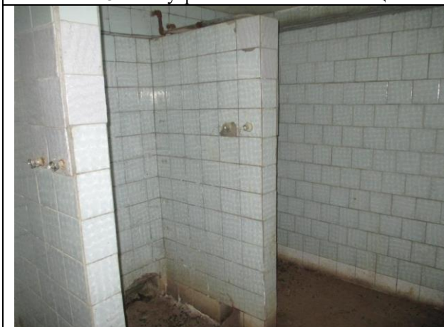
Фото № 33 – Внутреннее состояние помещения
