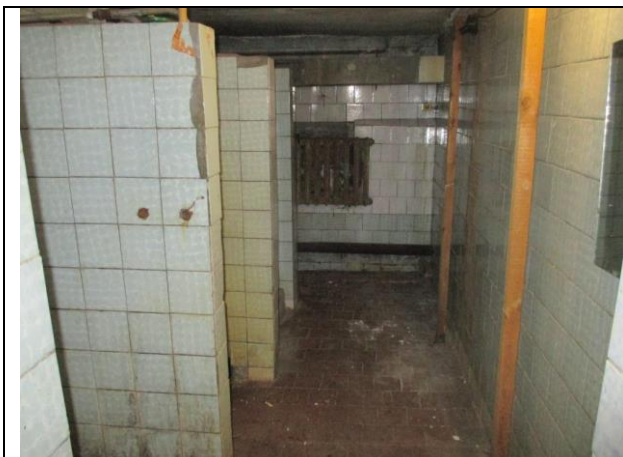
Фото № 23 – Внутреннее состояние помещения
