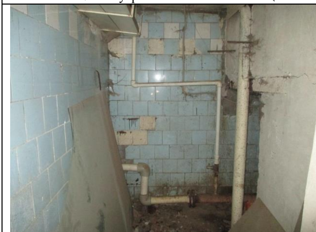
Фото № 29 – Внутреннее состояние помещения
