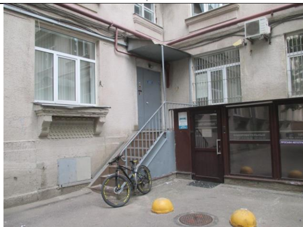
Фото № 5 – Общий вход в помещение
