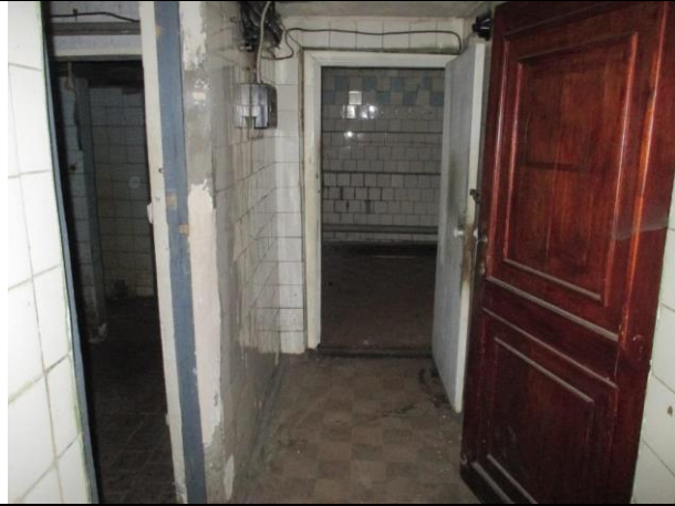
Фото № 17 – Внутреннее состояние помещения
