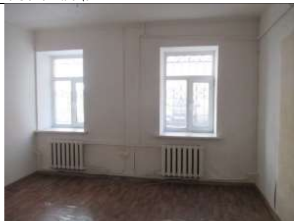
Фото 8. Внутреннее состояние Объекта оценки
