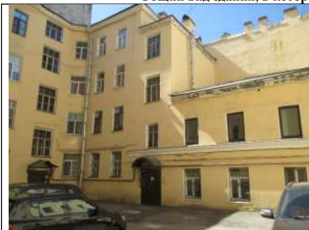
Фото 1. Вид здания, в котором расположен Объект оценки
