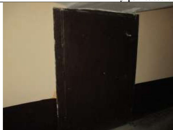
Фото 7. Внутреннее состояние Объекта оценки
