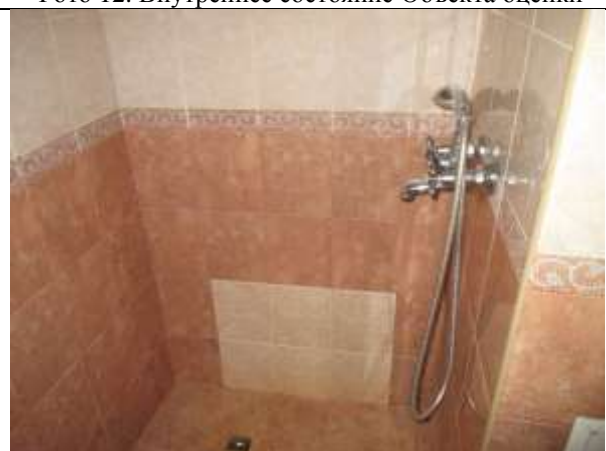
Фото 14. Внутреннее состояние Объекта оценки
