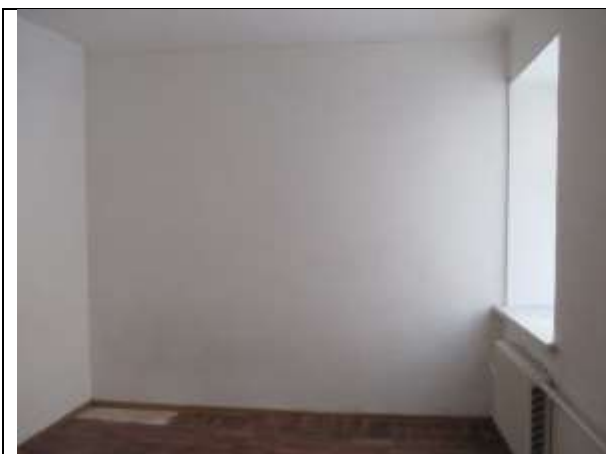
Фото 9. Внутреннее состояние Объекта оценки
