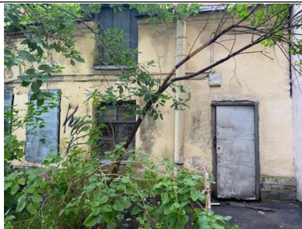
Фото № 10. Внешний вид здания
