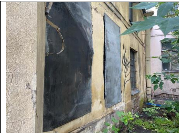
Фото № 9. Внешний вид здания
