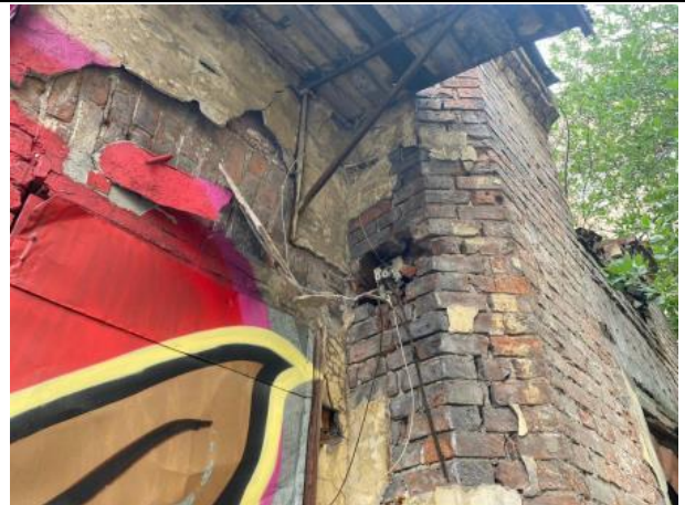
Фото № 4. Внешний вид здания
