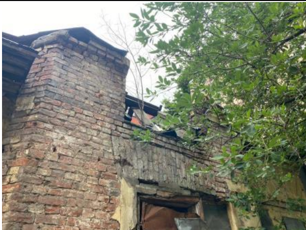
Фото № 5. Внешний вид здания
