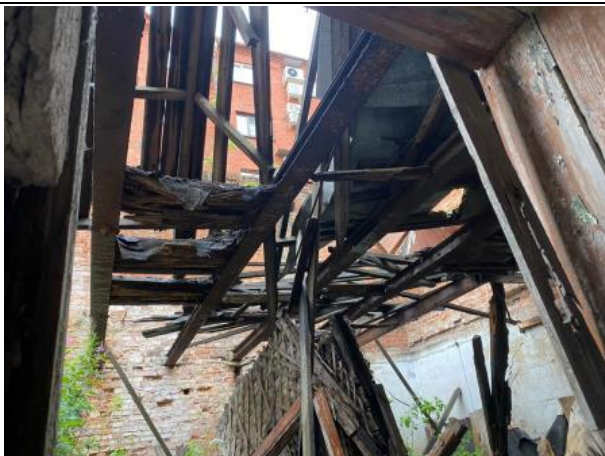
Фото № 7. Внешний вид здания
