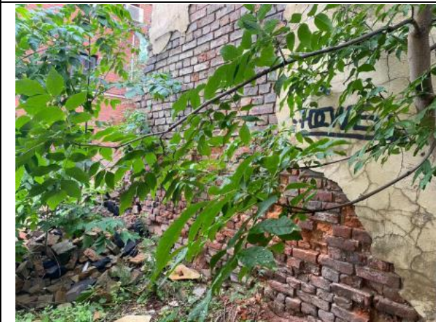
Фото № 11. Внешний вид здания
