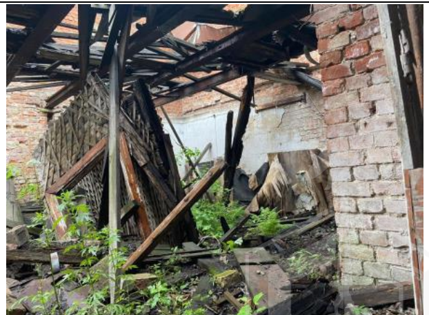
Фото № 8. Внешний вид здания
