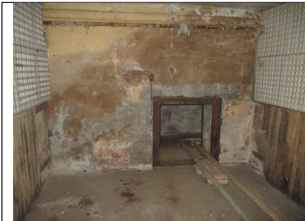
Фото № 31 – Внутреннее состояние помещения
