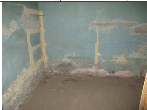
Фото № 26 – Внутреннее состояние помещения
