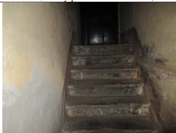
Фото № 36 – Внутреннее состояние помещения
