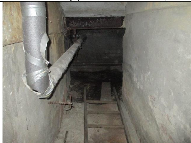
Фото № 34 – Внутреннее состояние помещения
