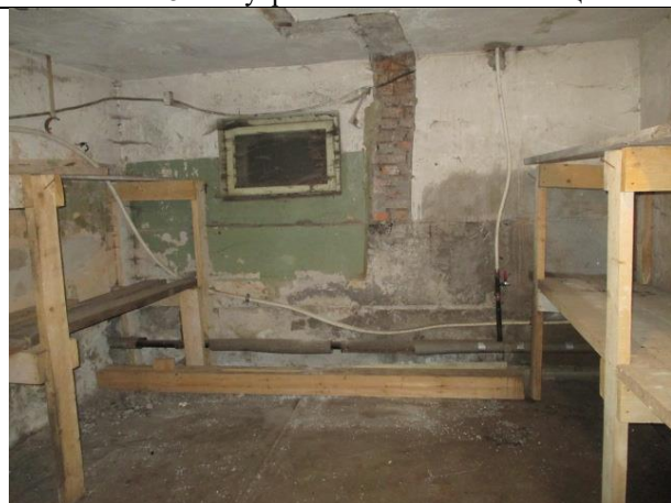
Фото № 18 – Внутреннее состояние помещения
