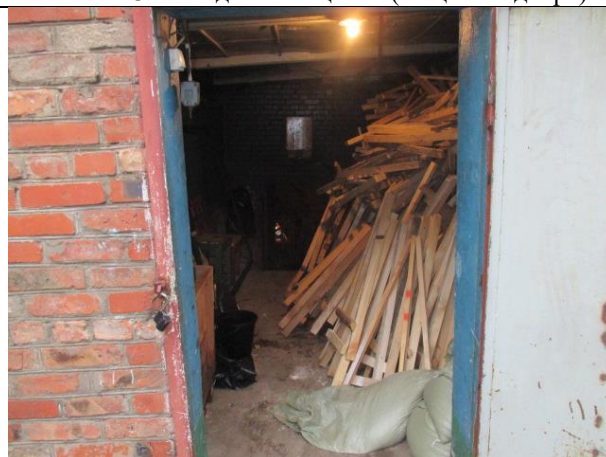
Фото № 10 – Внутреннее состояние помещения
