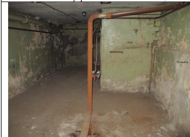
Фото № 37 – Внутреннее состояние помещения
