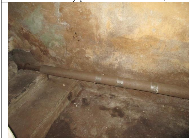
Фото № 35 – Внутреннее состояние помещения
