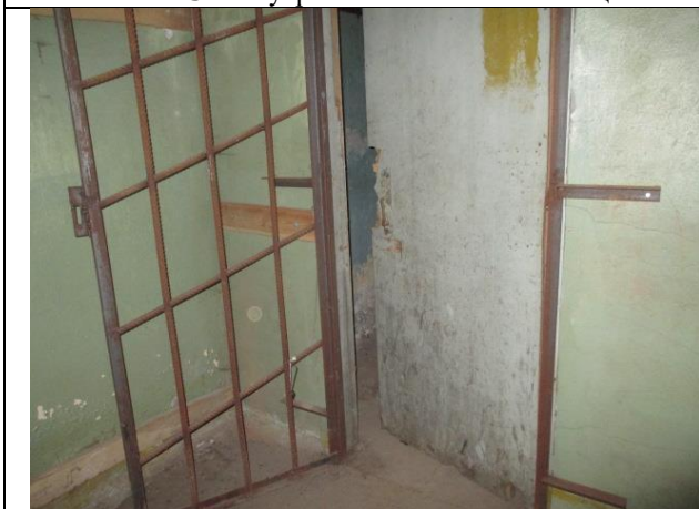
Фото № 25 – Внутреннее состояние помещения
