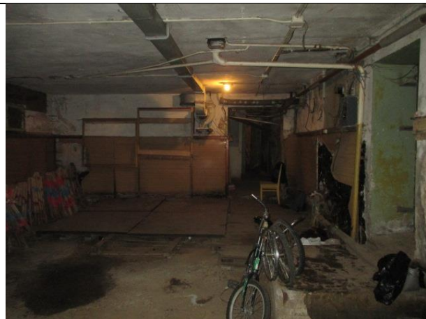
Фото № 16 – Внутреннее состояние помещения
