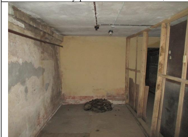
Фото № 29 – Внутреннее состояние помещения
