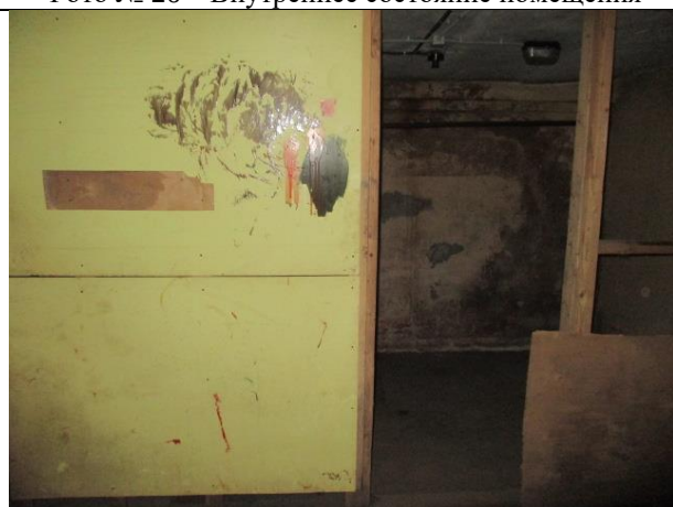
Фото № 28 – Внутреннее состояние помещения
