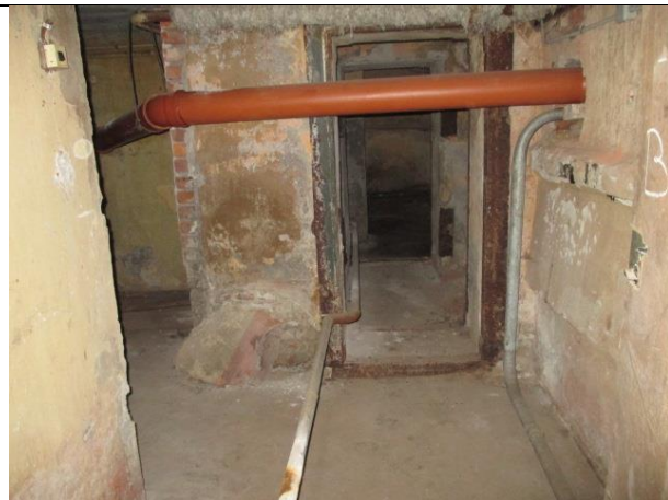
Фото № 32 – Внутреннее состояние помещения
