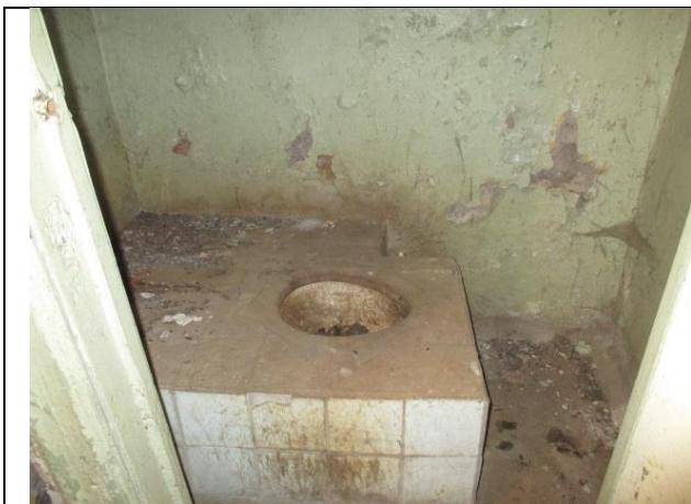
Фото № 23 – Внутреннее состояние помещения
