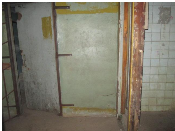
Фото № 24 – Внутреннее состояние помещения
