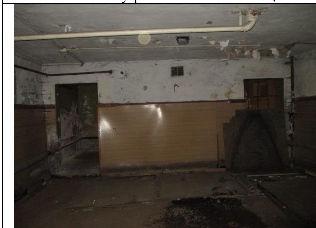
Фото № 13 – Внутреннее состояние помещения
