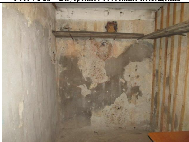
Фото № 20 – Внутреннее состояние помещения
