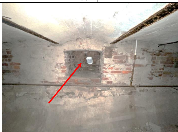
Фото 36. Оконная группа Объекта оценки (помещение 27-Н)
