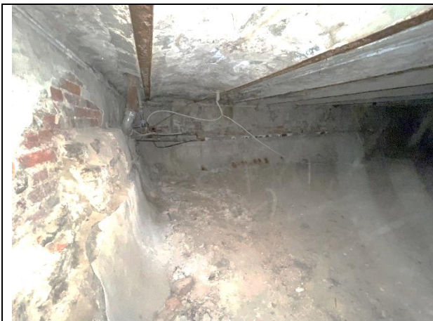
Фото 39. Типичное состояние Объекта оценки (помещение 27-Н)
