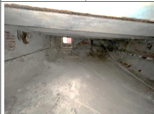
Фото 37. Типичное состояние Объекта оценки (помещение 27-Н)
