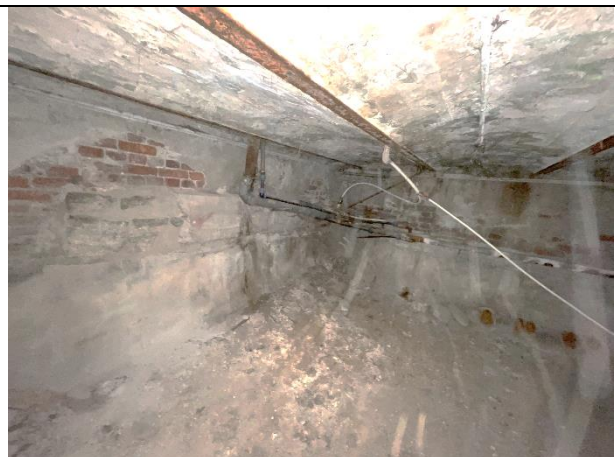
Фото 40. Типичное состояние Объекта оценки (помещение 27-Н)
