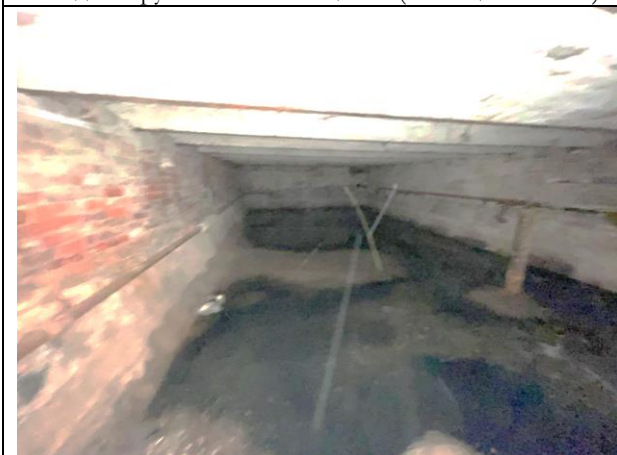
Фото 35. Типичное состояние Объекта оценки (помещение 13-Н)
