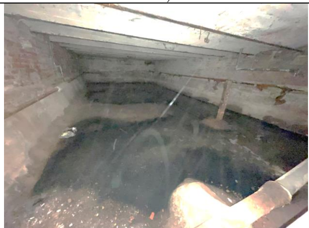
Фото 36. Типичное состояние Объекта оценки (помещение 13-Н)
