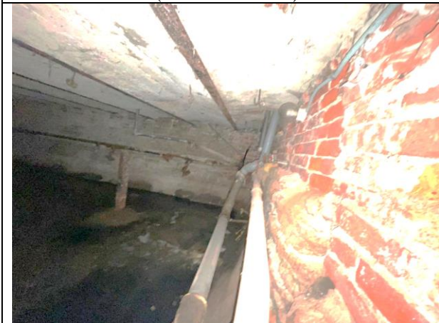
Фото 37. Типичное состояние Объекта оценки (помещение 13-Н)
