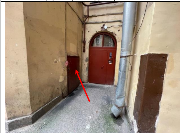
Фото 33. Вид здания расположения Объекта оценки, входная группа Объекта оценки (помещение 13-Н)
