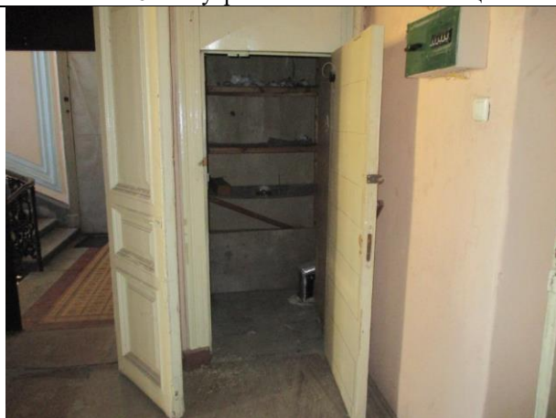
Фото № 18 – Внутреннее состояние помещения
