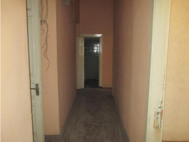
Фото № 7 – Внутреннее состояние помещения
