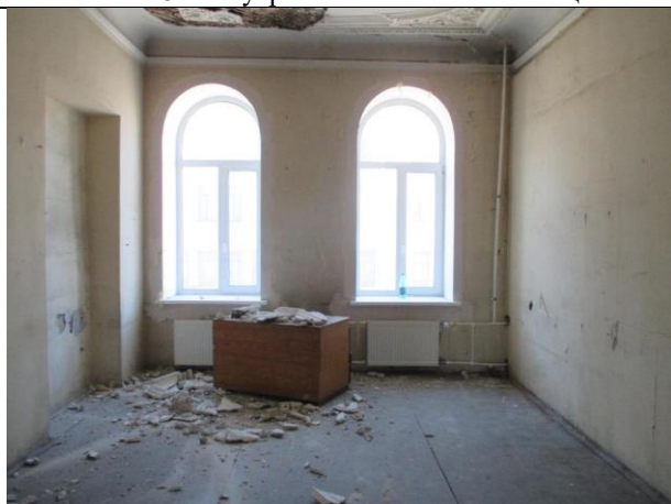
Фото № 17 – Внутреннее состояние помещения
