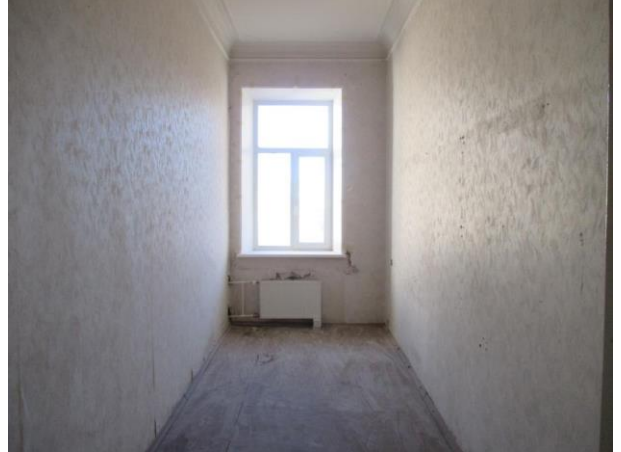
Фото № 8 – Внутреннее состояние помещения
