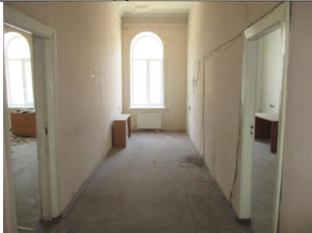
Фото № 16 – Внутреннее состояние помещения
