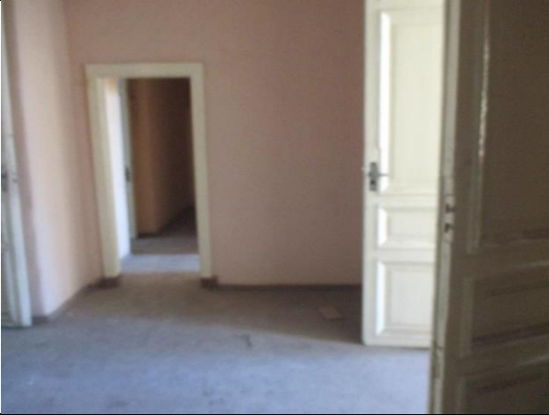
Фото № 5 – Внутреннее состояние помещения
