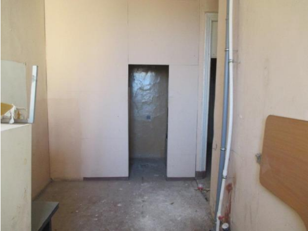
Фото № 11 – Внутреннее состояние помещения
