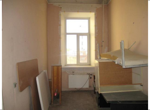
Фото № 10 – Внутреннее состояние помещения
