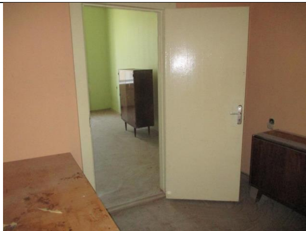
Фото № 14 – Внутреннее состояние помещения
