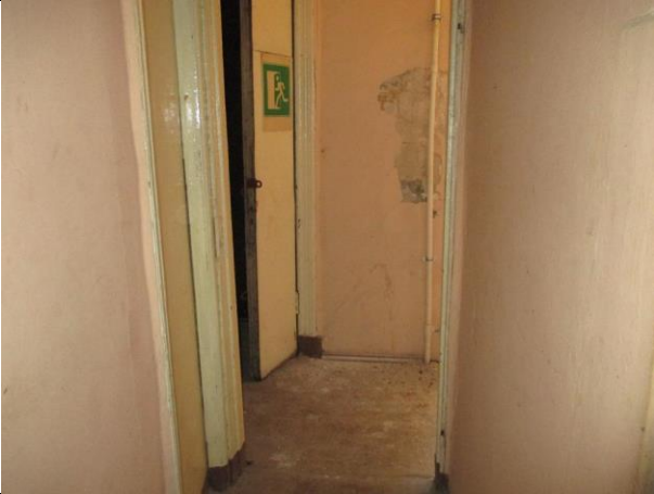
Фото № 9 – Внутреннее состояние помещения
