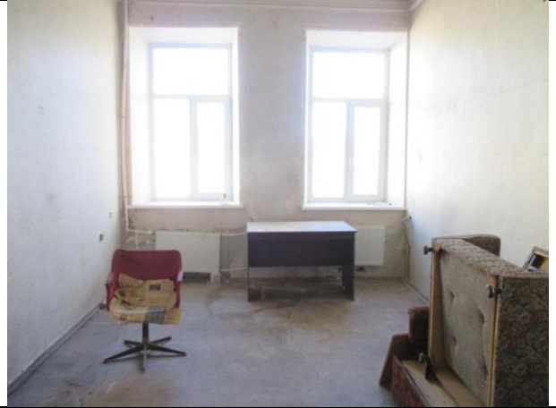
Фото № 6 – Внутреннее состояние помещения
