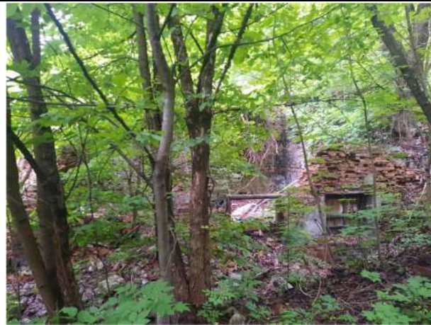
Фото № 12. Внешний вид здания литера В
