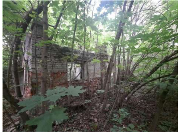
Фото № 6. Внешний вид здания литеры З
