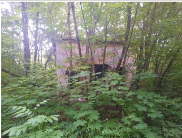
Фото № 7. Внешний вид здания литеры Д
