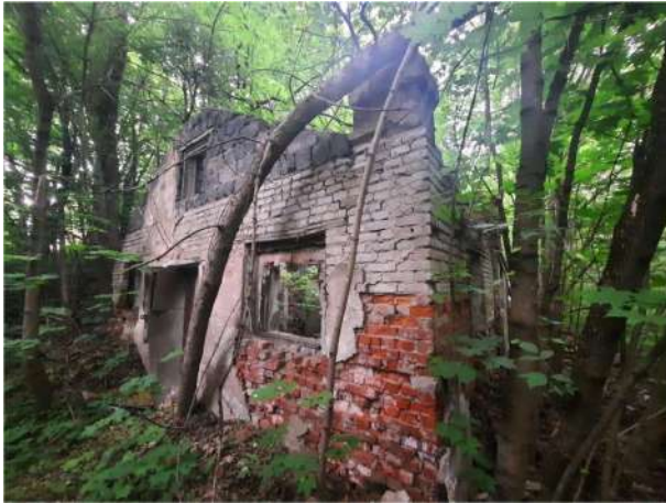
Фото № 5. Внешний вид здания литеры З
