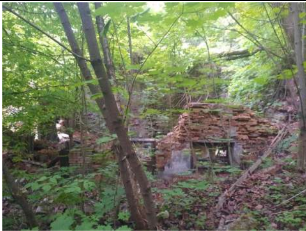
Фото № 11. Внешний вид здания литера В
