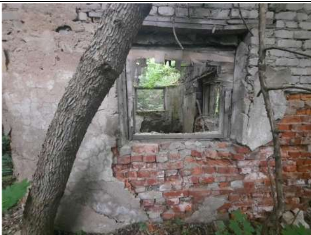
Фото № 9. Внешний вид здания литеры Д
