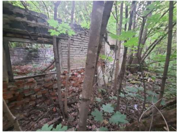
Фото № 4 Внешний вид здания литеры З
