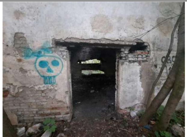
Фото № 8. Внешний вид здания литеры Д
