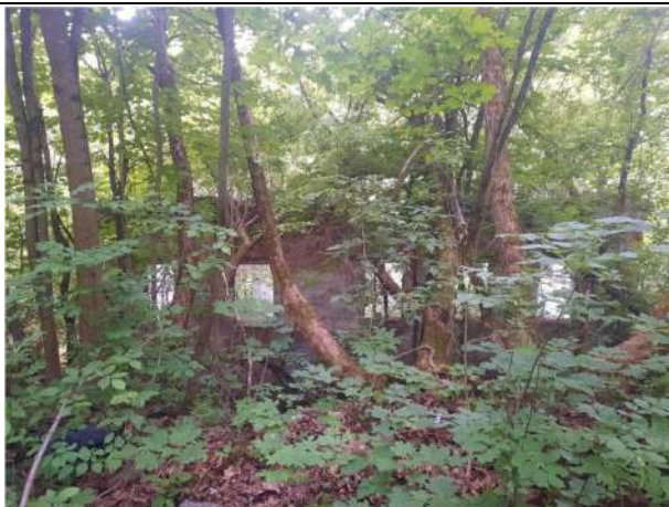
Фото № 17. Внешний вид здания литера А
