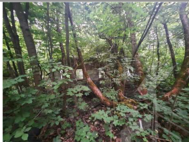
Фото № 18. Внешний вид здания литера А
