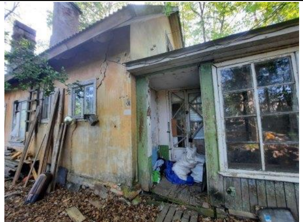
Фото № 6. Внешний вид здания литера А
