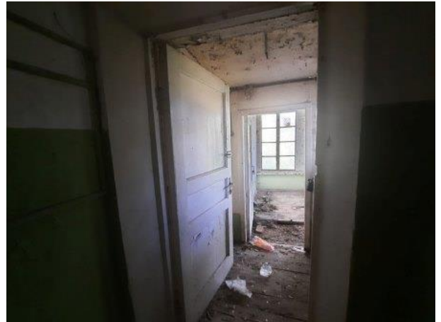
Фото № 20. Внутреннее состояние здание литеры Б
