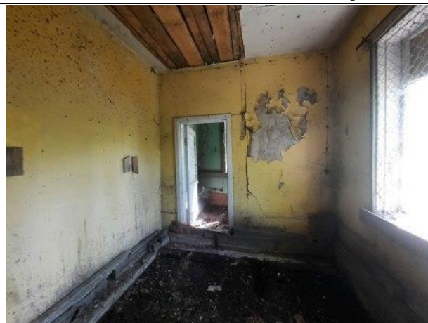
Фото № 30. Внутреннее состояние здание литеры В
