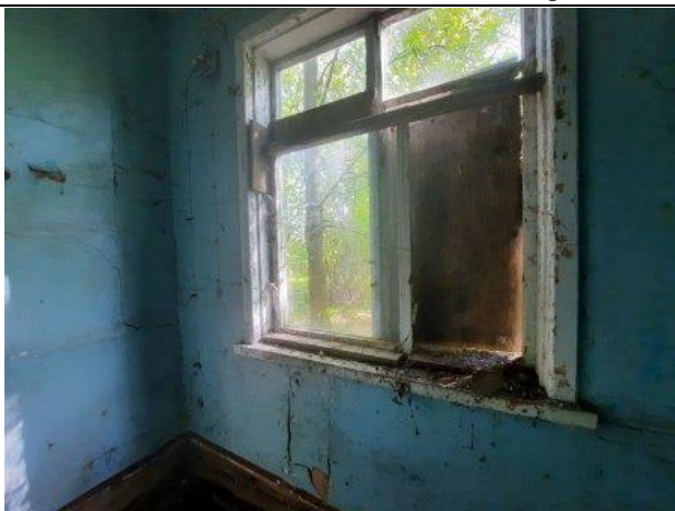
Фото № 29. Внутреннее состояние здание литеры В
