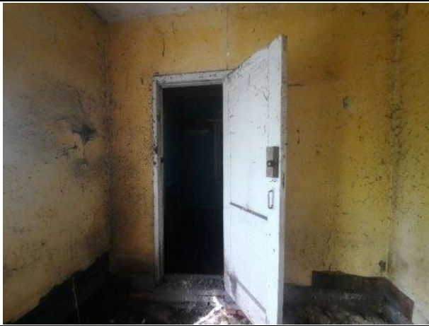
Фото № 33. Внутреннее состояние здание литеры В
