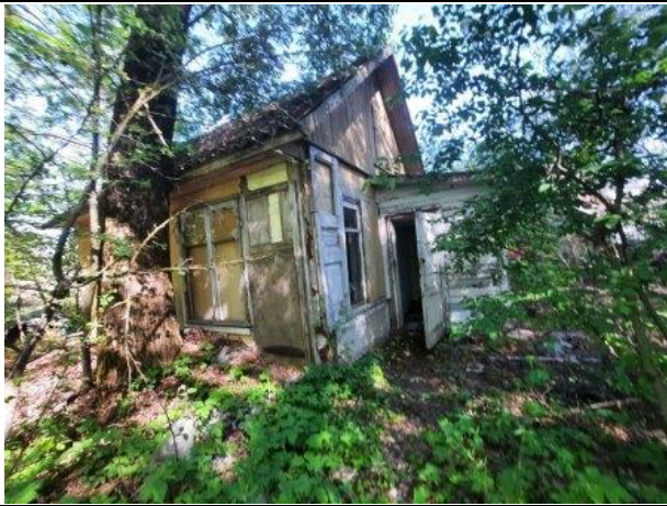
Фото № 41. Внешний вид здания литеры Е
