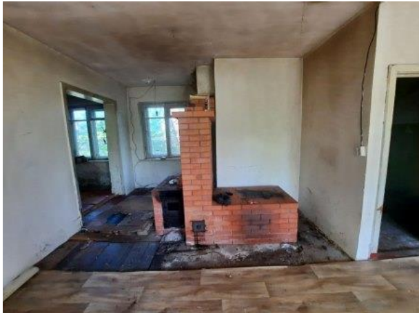
Фото № 19. Внутреннее состояние здание литеры Б
