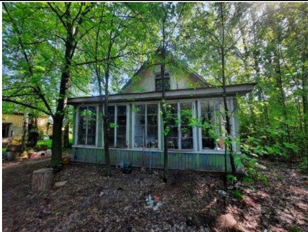
Фото № 5. Внешний вид здания литера А
