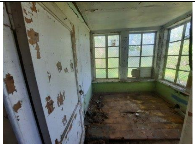
Фото № 22. Внутреннее состояние здание литеры Б
