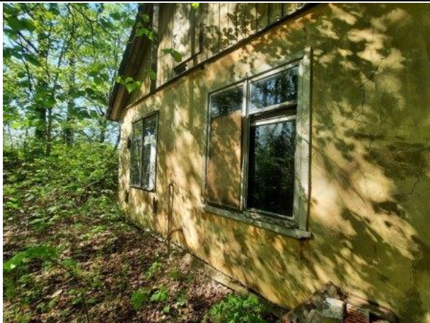
Фото № 27. Внешний вид здания литеры В
