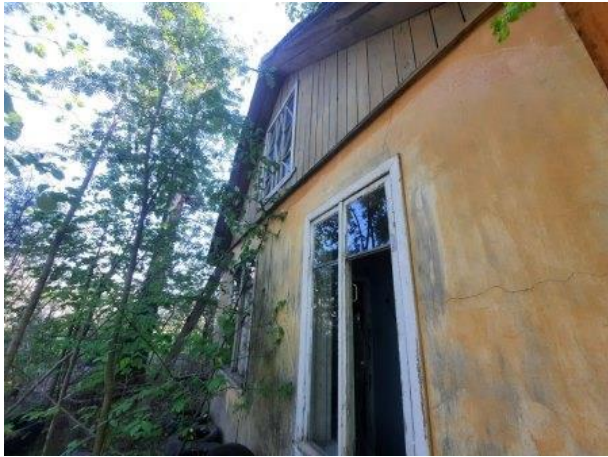
Фото № 43. Внешний вид здания литеры Е
