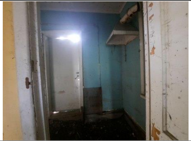
Фото № 34. Внутреннее состояние здание литеры В
