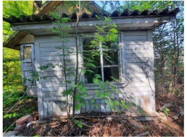
Фото № 44. Внешний вид здания литеры Е
