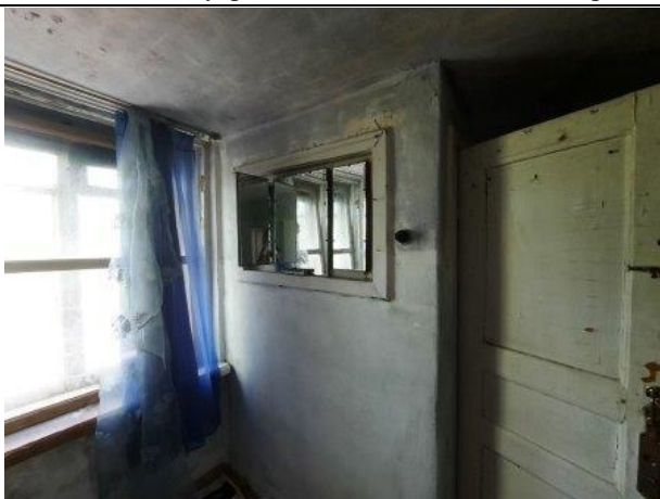
Фото № 21. Внутреннее состояние здание литеры Б
