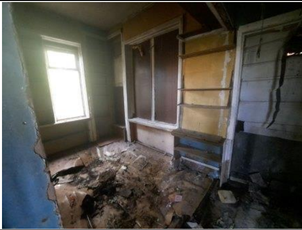
Фото № 49. Внутреннее состояние здание литеры Е
