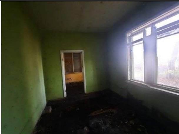
Фото № 31. Внутреннее состояние здание литеры В
