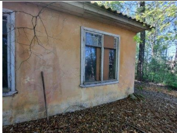
Фото № 28. Внешний вид здания литеры В
