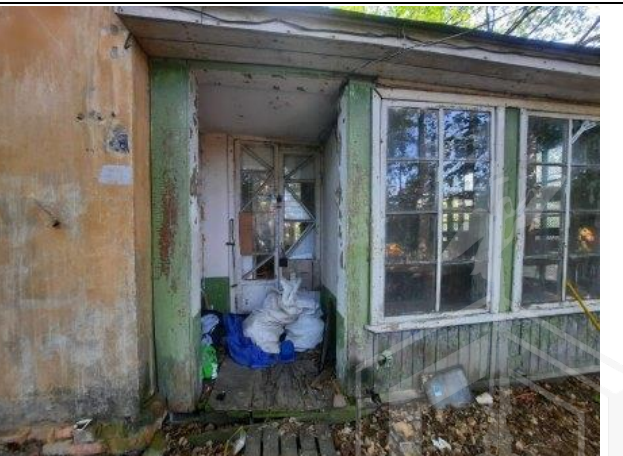
Фото № 8. Внешний вид здания литера А
