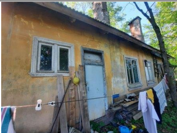
Фото № 7. Внешний вид здания литера А
