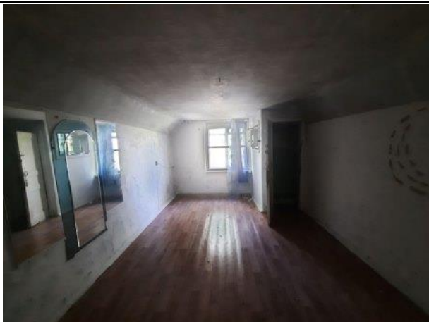
Фото № 23. Внутреннее состояние здание литеры Б
