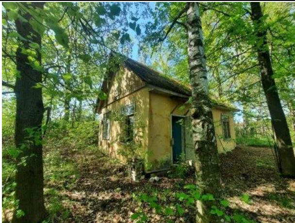
Фото № 25. Внешний вид здания литеры В
