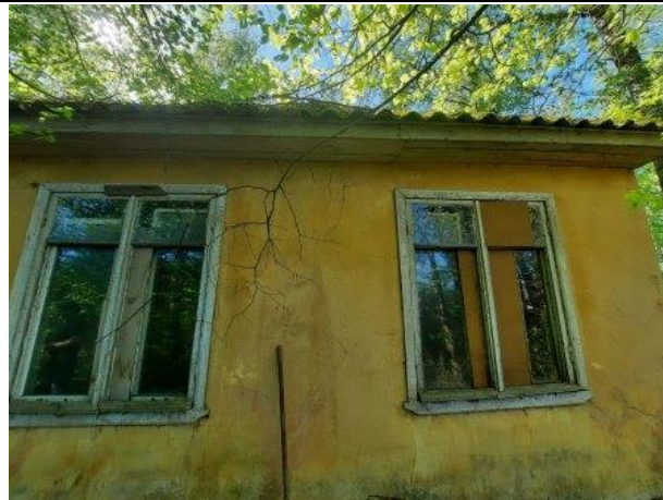
Фото № 26. Внешний вид здания литеры В
