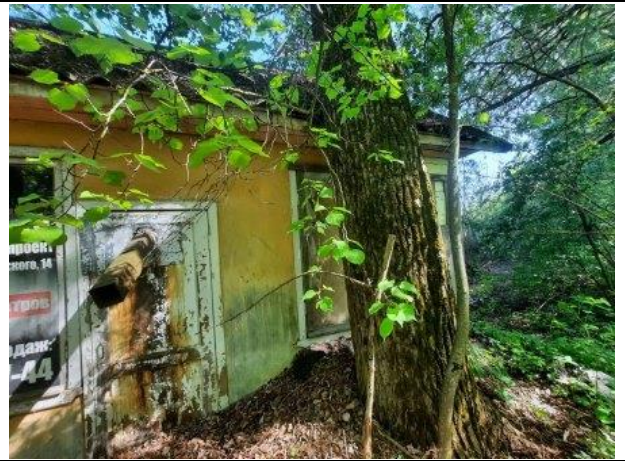
Фото № 42. Внешний вид здания литеры Е
