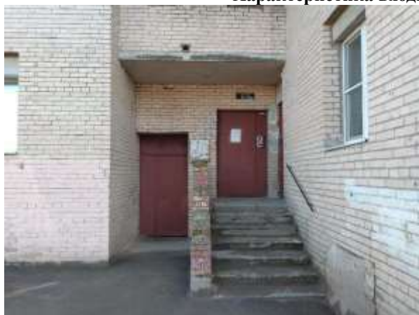
Фото 3. Общий вход с улицы
