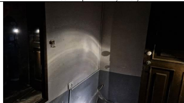
Фото 25. Типичное состояние Объекта оценки
