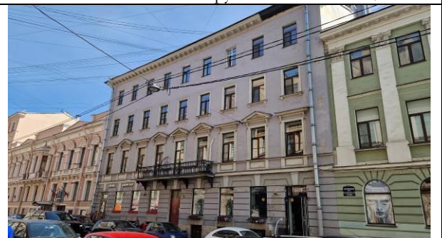
Фото 14. Вид здания Объекта оценки
