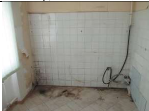
Фото 14. Внутреннее состояние Объекта оценки
