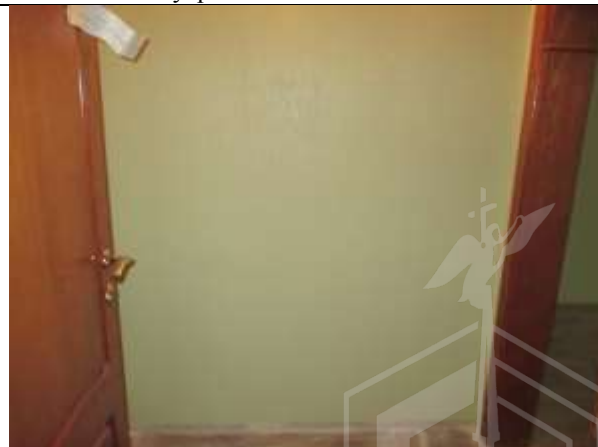
Фото 18. Внутреннее состояние Объекта оценки
