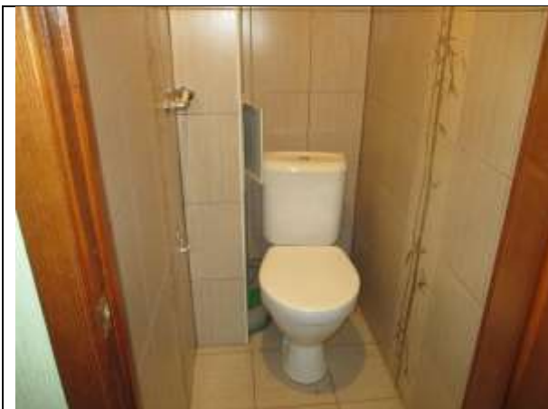
Фото 11. Внутреннее состояние Объекта оценки
