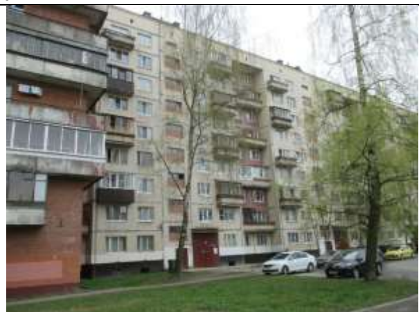
Фото 2. Вид здания, в котором расположен Объект оценки
