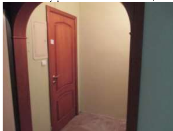
Фото 16. Внутреннее состояние Объекта оценки
