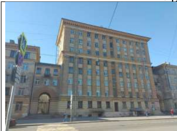
Фото 1. Вид здания, в котором расположен Объект оценки
