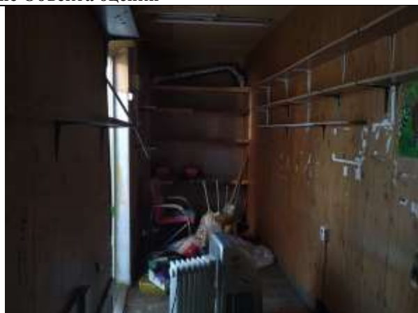
Фото 6. Внутреннее состояние Объекта оценки
