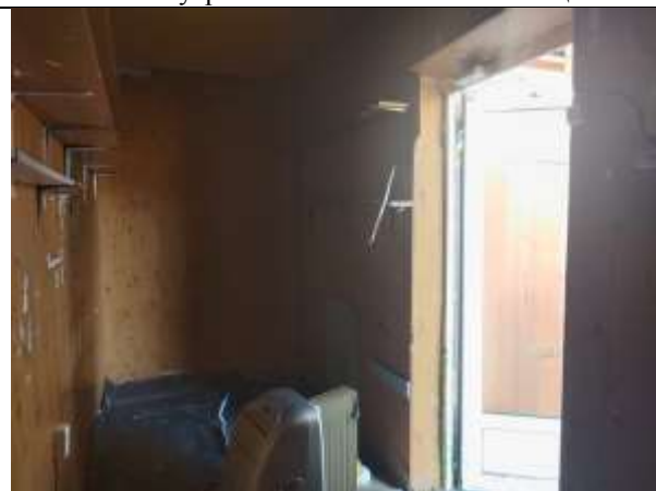
Фото 7. Внутреннее состояние Объекта оценки
