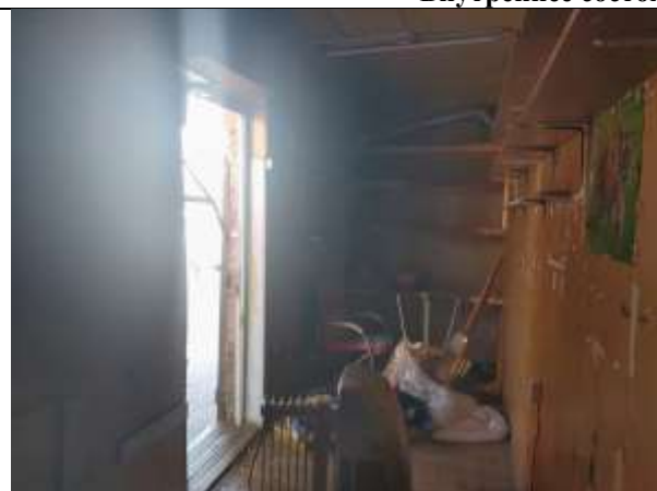
Фото 5. Внутреннее состояние Объекта оценки
