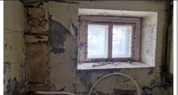
Фото 26. Типичное состояние Объекта оценки
