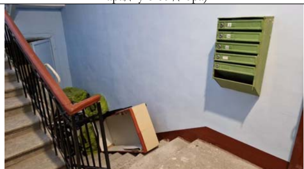
Фото 16. Состояние парадной Объекта оценки
