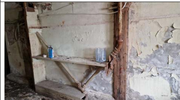
Фото 27. Типичное состояние Объекта оценки
