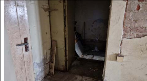
Фото 25. Типичное состояние Объекта оценки
