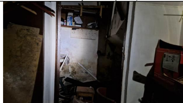
Фото 25. Типичное состояние Объекта оценки
