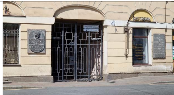
Фото 16. Проход через арку к Объекту оценки (с набережной реки Фонтанки)
