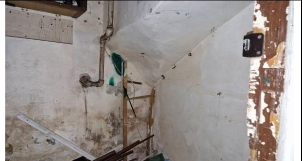
Фото 24. Типичное состояние Объекта оценки
