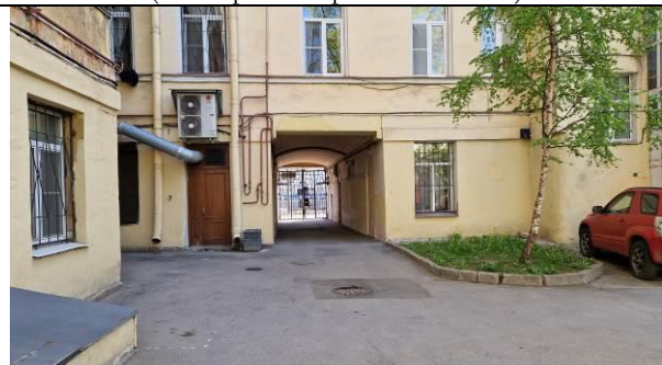
Фото 18. Внутридворовая территория Объекта оценки (выход на набережную реки Фонтанки)
