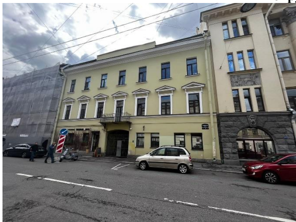
Фото 1. Вид здания, в котором расположен Объект оценки
