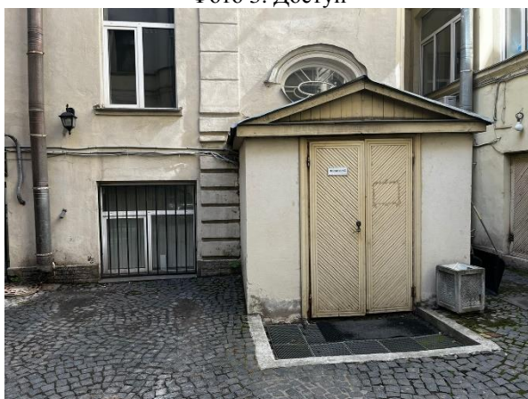
Фото 5. Общий вход со двора пом. 8-Н
