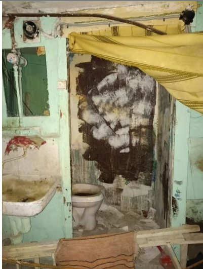
Фото № 7 – Внутреннее состояние помещения
