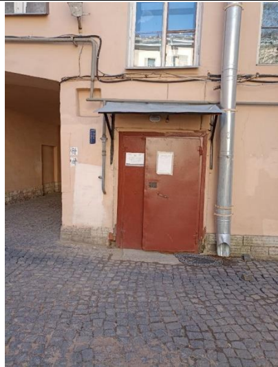
Фото № 4 – Общий вход в помещение со двора
