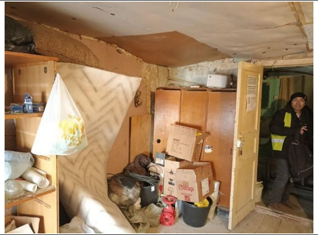
Фото № 10 – Внутреннее состояние помещения
