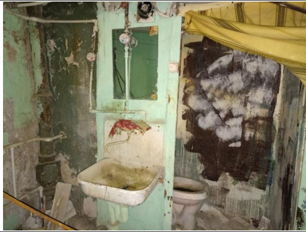
Фото № 9 – Внутреннее состояние помещения
