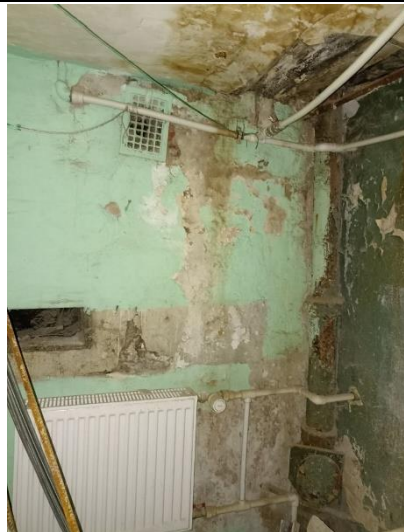
Фото № 6 – Внутреннее состояние помещения
