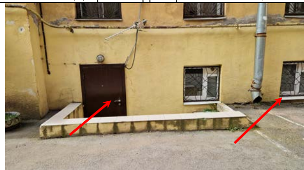
Фото 15. Входная и оконная группа Объекта оценки
