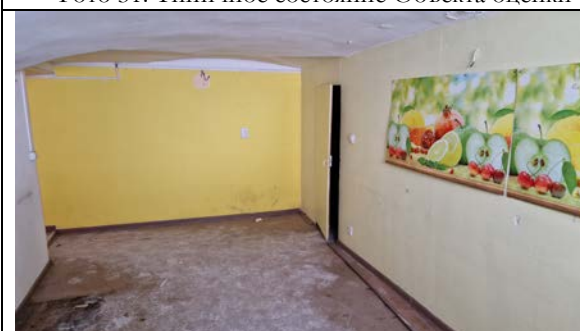
Фото 33. Типичное состояние Объекта оценки
